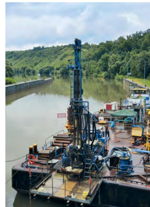
Insgesamt wurden 17 zusätzliche Kernbohrungen erforderlich, von denen acht Stück im Wasser lagen und vom Ponton aus gebohrt werden mussten (Bild 3). Zwei der Bohrungen wurden zu Grundwassermessstellen ausgebaut. Zusätzlich wurden zwei quartäre Grundwassermessstellen hergestellt und je sieben Druck- und Rammsondierungen ausgeführt. Die Bewertung der Bohrkerne durch das Referat Grundbau bestätigte den extrem heterogenen und ungünstigen Aufbau des Baugrundes.
