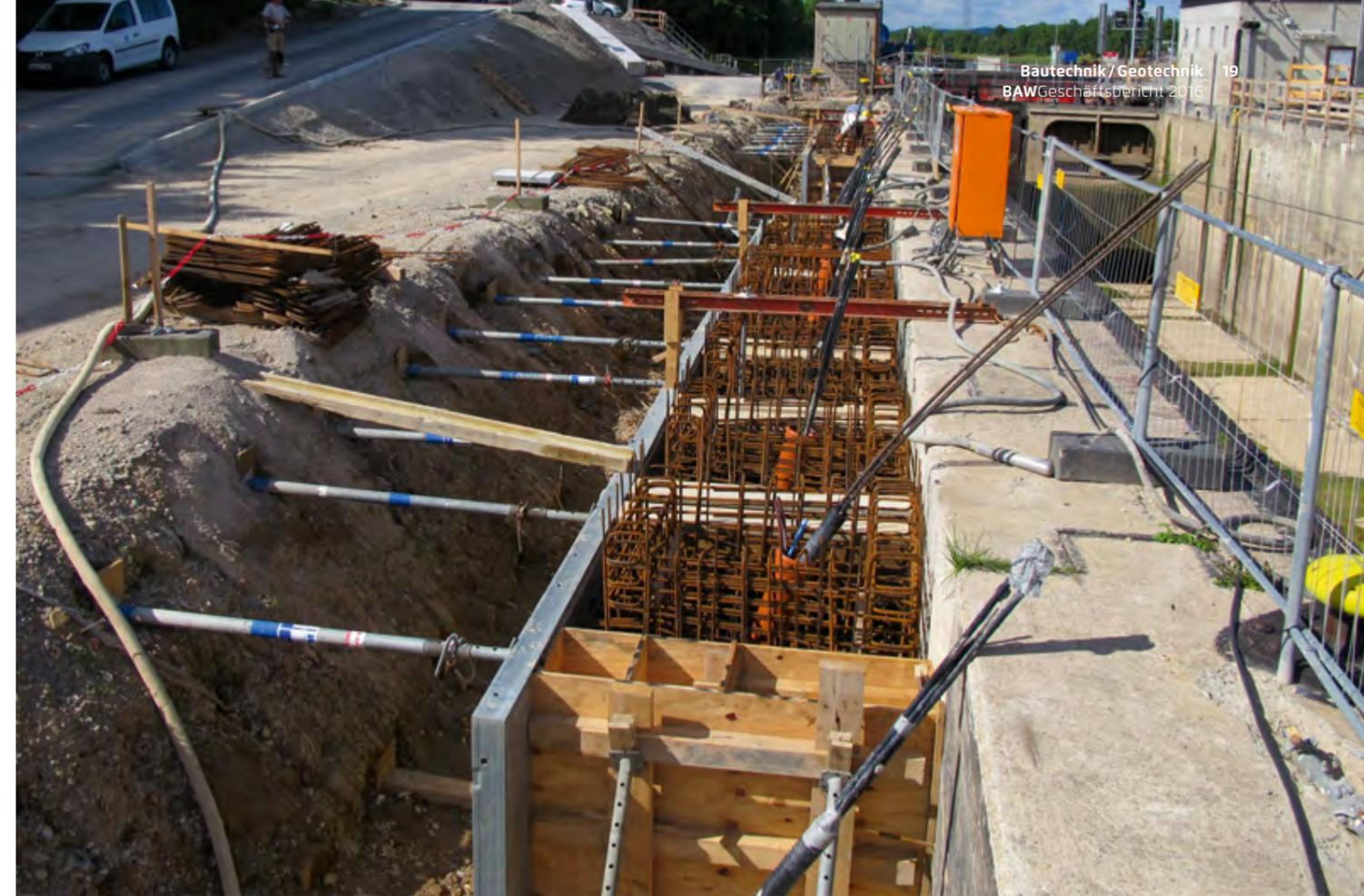
Bild 6: Verankerung der Kammerwände der Schleuse Aldingen
