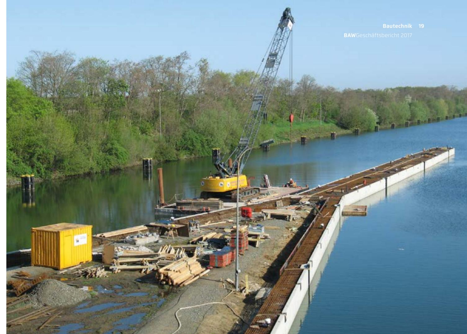
Bild 5: Instandsetzung Mole Schleuse Üfingen mit vorgehängten Fertigteilen
