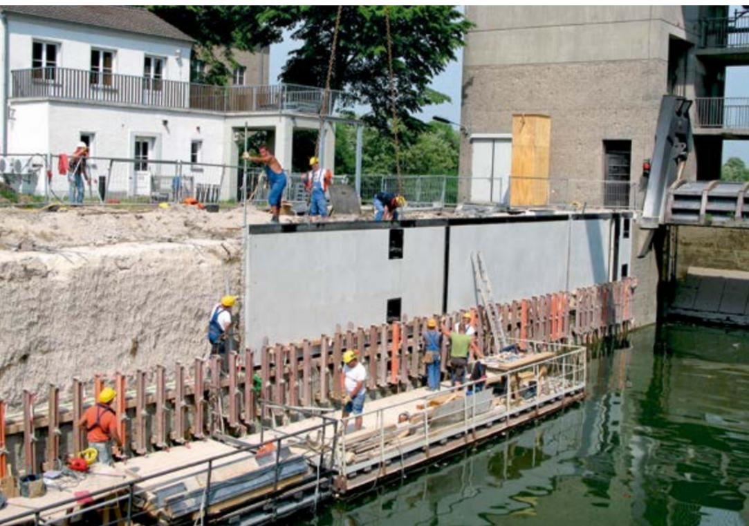
Bild 6: Instandsetzung oberer Kammerwandbereich der Schleuse Wedtlenstedt
