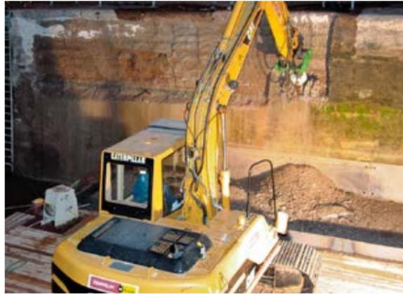
Bild 3: Betonabtrag durch Fräsen in nächtlicher Sperrpause
