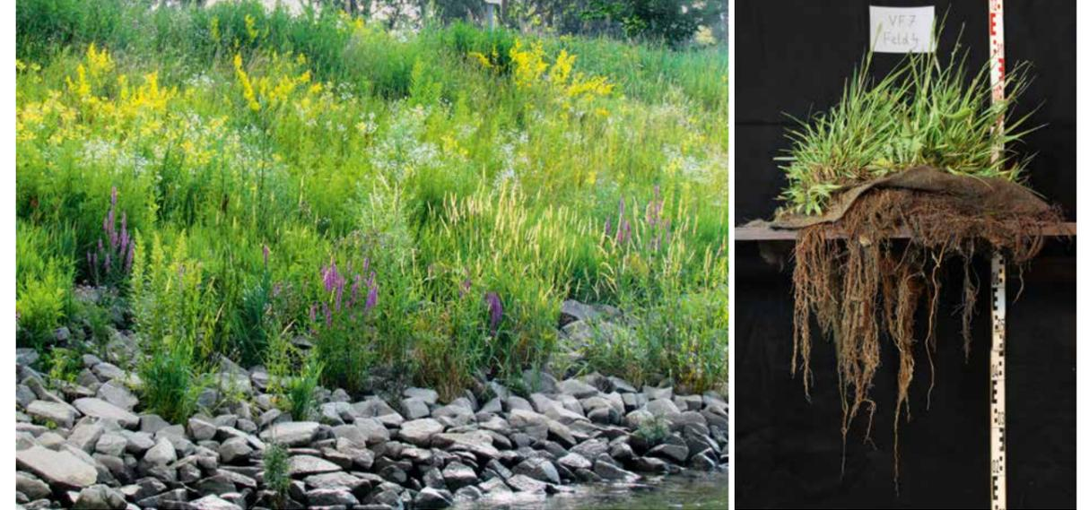
Bild 2: Gut entwickelte Pflanzmatten in der oberen Böschungshälfte, freigelegte Wurzeln (2017)
