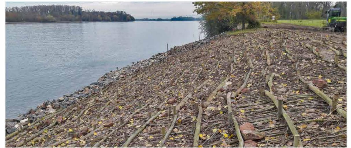
Bild 5: Bauausführung Weidenspreitlage zur Ufersicherung am Kühkopf/Rhein
