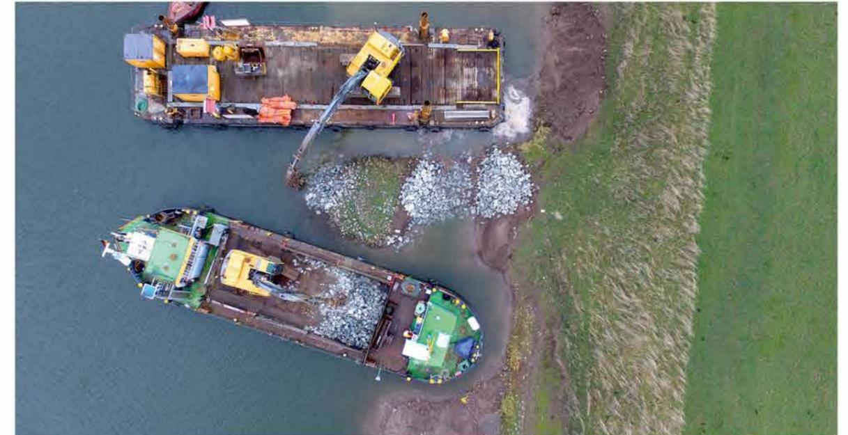
Bild 7: Bauliche Anpassung einer Buhne im Unterwasser der Staustufe Schlüsselburg mit dem Ziel der ökologischen Aufwertung dieses Bereichs
