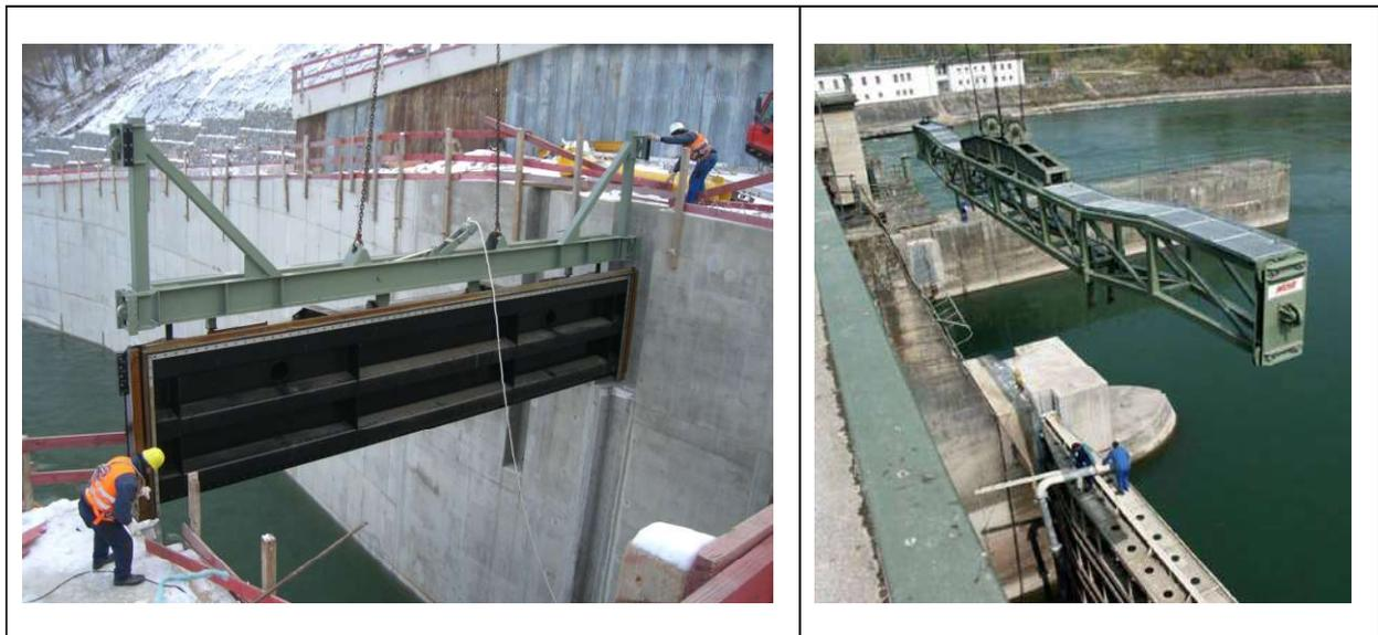
**Abb. 80:** Beispiele für Anhängervorrichtung für Dammtafeln (links: nach SWB 2011; rechts: nach MUHR 2014)
