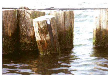
Abb. 1: „Wanderung“ eines Buhnenpfehles aus der Pfahlreihe
