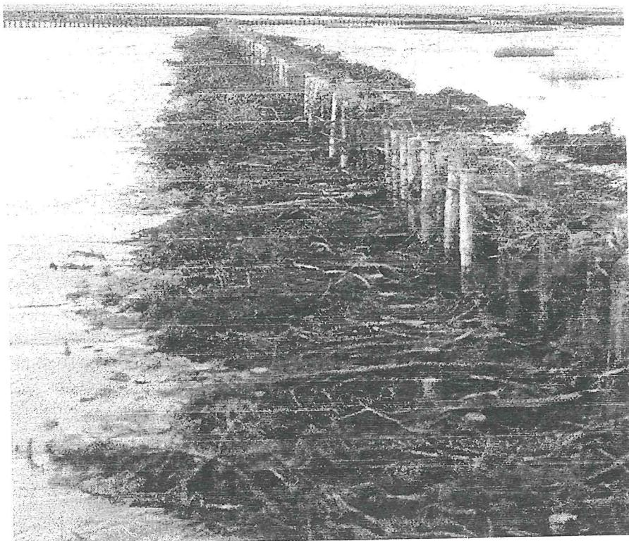
Anl. A 3-3a: Mit Faschinendeckwerk verstärkte Buschlahnung;
