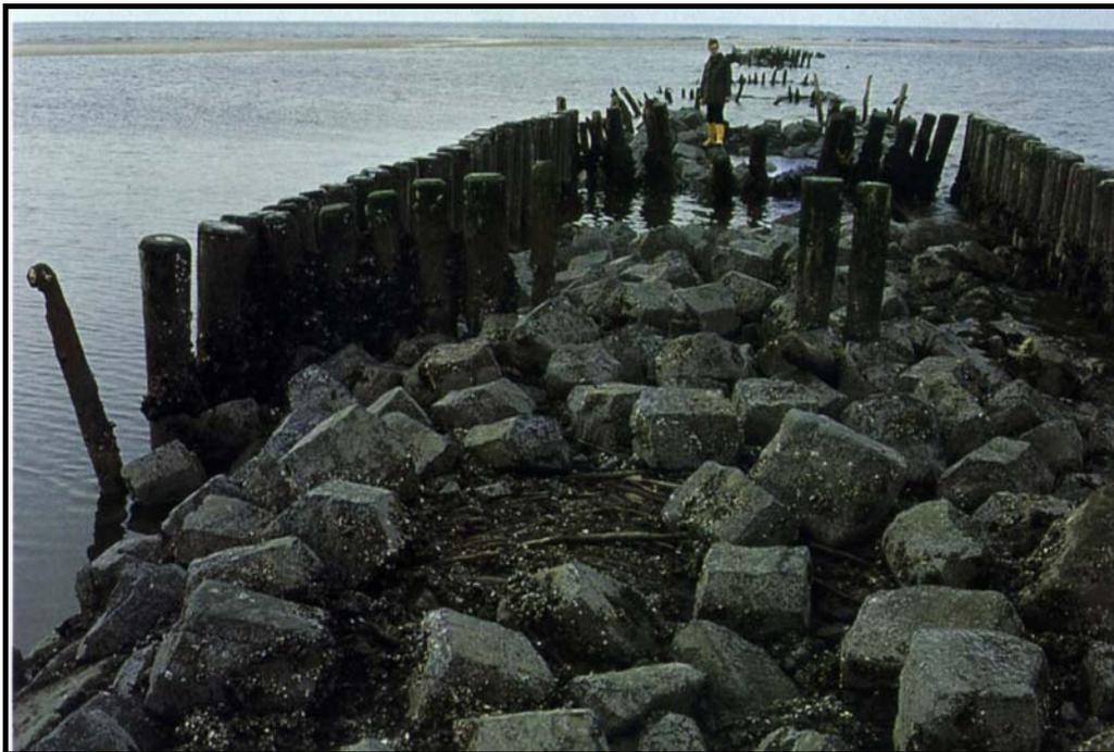
Abb. 3.10: Beschädigte Buhne auf Wangerooge (1979).
