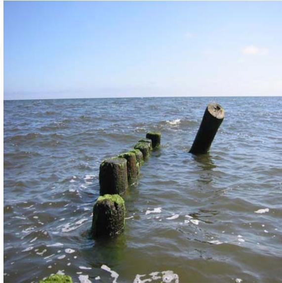
Abb. 32: : Durch Eishub aus dem Boden gezogener Pfahl. Die verminderte Einspannlänge reichte nicht aus, um die Standsicherheit zu gewährleisten, und führte zu einer Schrägstellung (Usedom)
