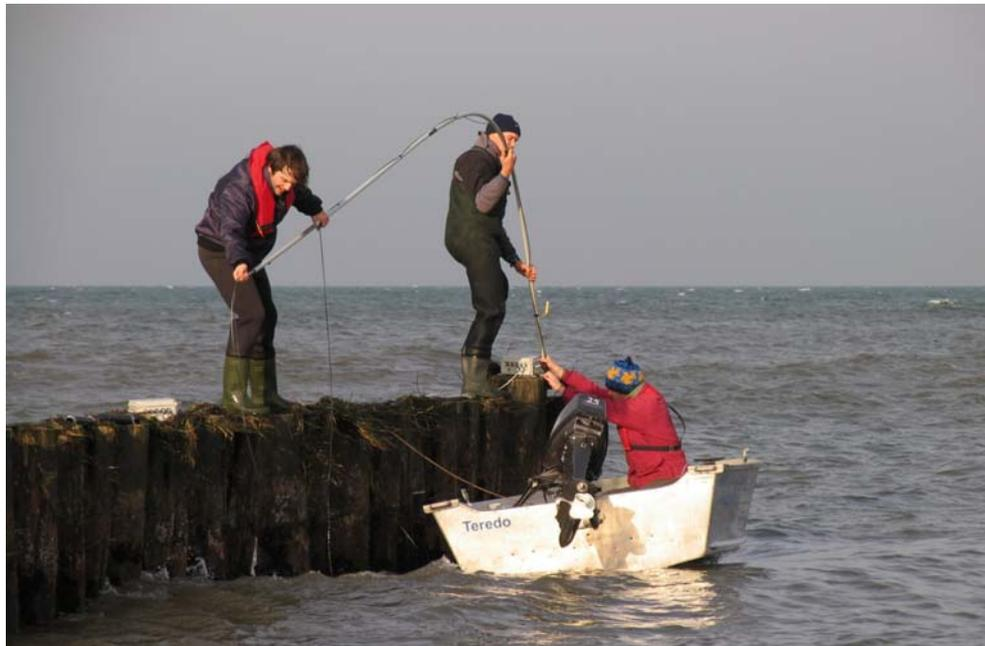
Abb. 14: Einbau von Beschleunigungssensoren
