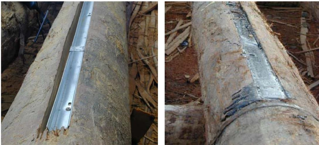
Abb. 12: In den Pfahl eingelassener Metallkabelkanal und Endzustand mit Verguss
