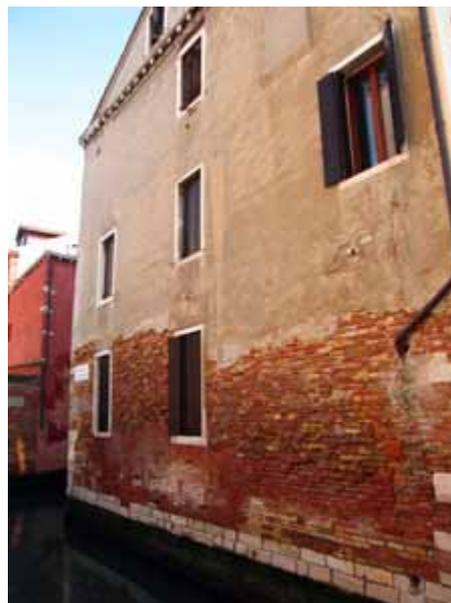
Abb. 6.1: Salzwasserschaden an Mauerwerksbau (Quelle: [http://courses.umass.edu/latour/Italy/venice\\_water/index.html](http://courses.umass.edu/latour/Italy/venice_water/index.html))
