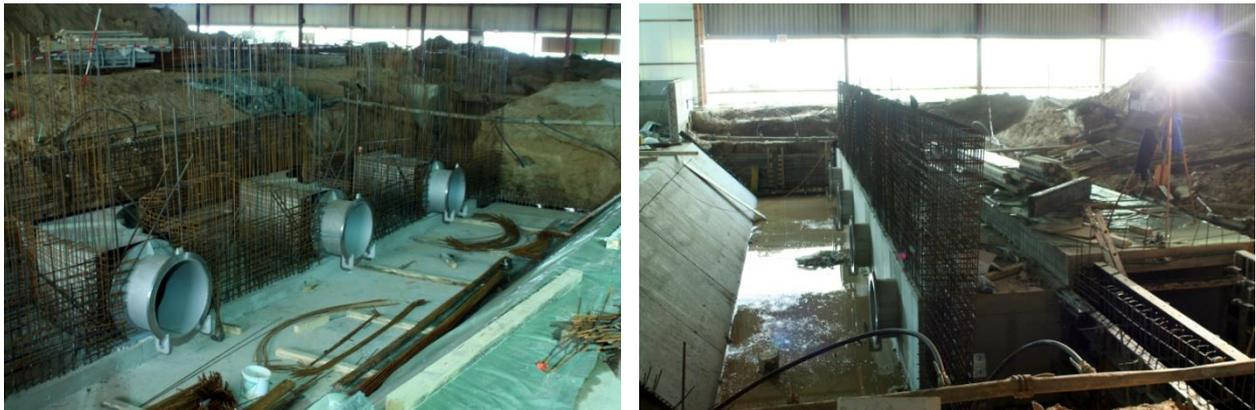
Abb. 3.6: Bewehrung um die Druckrohre im Bereich des Pumpensumpfes, Anschluss der Rezykulationspumpen und Übergang in den Rückführungskanal.
