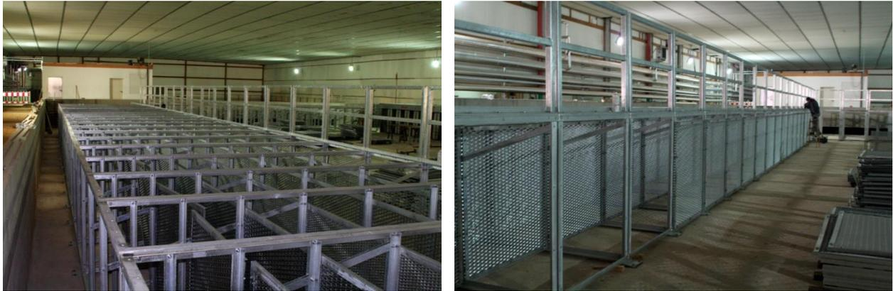
Abb. 3.9: links: rückseitige Ansicht der passiven Absorberelemente, vor der Montage der begehbare Gitterroste, rechts: vorderseitige Ansicht während der Montage.
