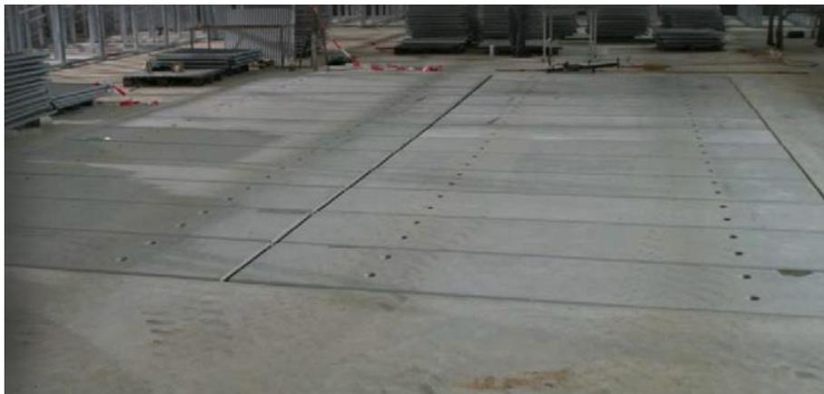
Abb. 5.16: Mit Betonplatten bedeckter modularer Tieftteil (Lieske 2015)
