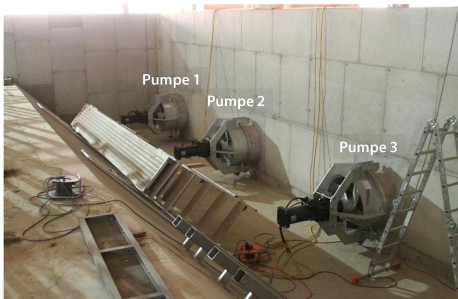
Abb. 3.7: Pumpensumpf der Strömungsanlage des 3D-Wellen-Strömungsbeckens
