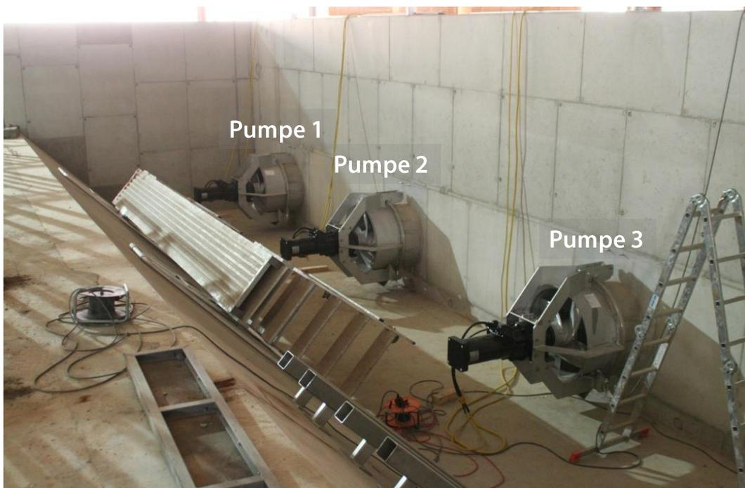
Abb. 4.5: Pumpensumpf der Strömungsanlage des 3D-Wellen-Strömungsbeckens
