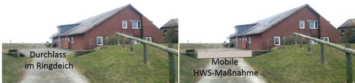
Abbildung 2-1: Möglicher Einsatz einer mobilen HWS-Maßnahme zum Verschluss einer Stöpe.
