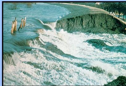
Wellenauflauf / -ablauf auf der Außenböschung
