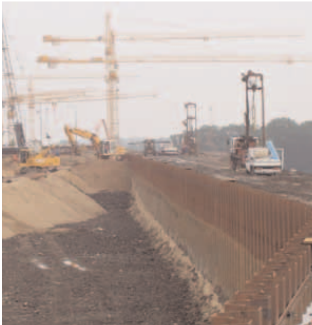
Abb. 1 Das Planum ist eine eben (plan) hergestellte Oberfläche, auf der (weitere) Baumaßnahmen stattfinden.
