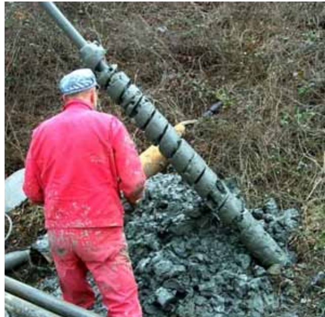
Abb. 2 Bindiges Bohrgut, das zum Verfüllen der Bohrlöcher ungeeignet ist
