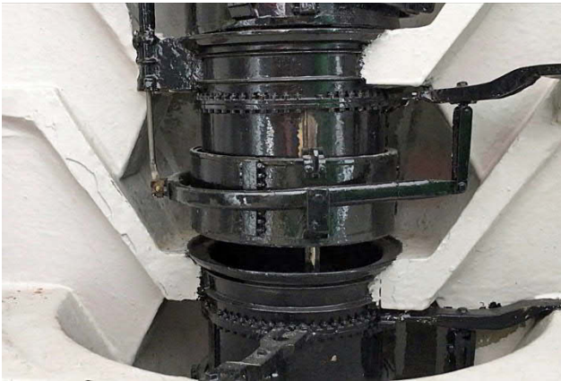
Bild 5: Modell des Zylinderschützes der Schleuse Anderten
