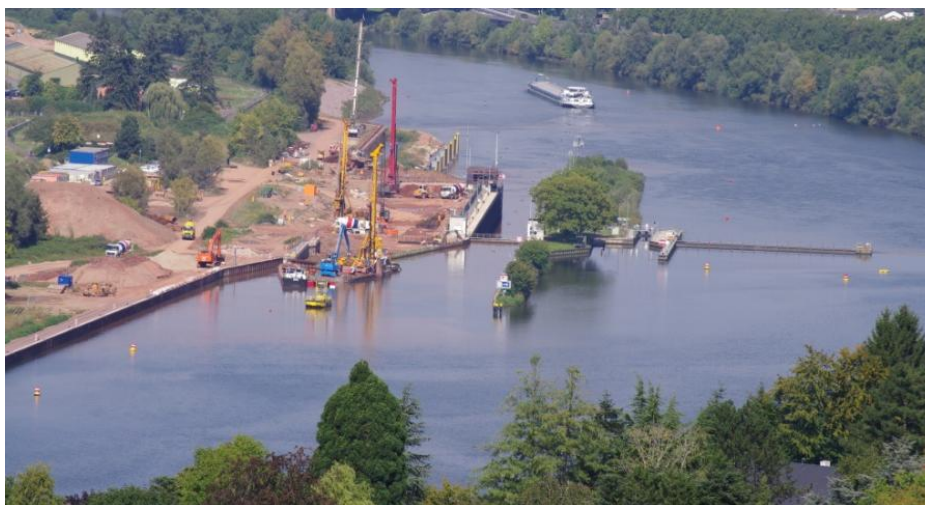
Bild 3: Zweite Schleuse Trier im Bau
