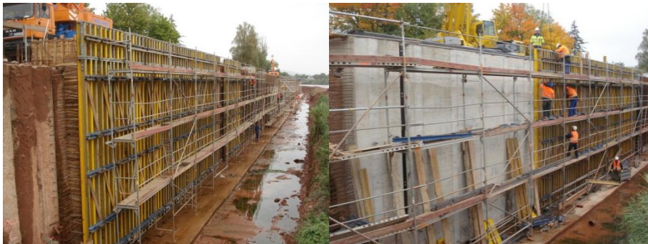
Bild 4: Unterer Vorhafen; Herstellung der Vorsatzschalung
