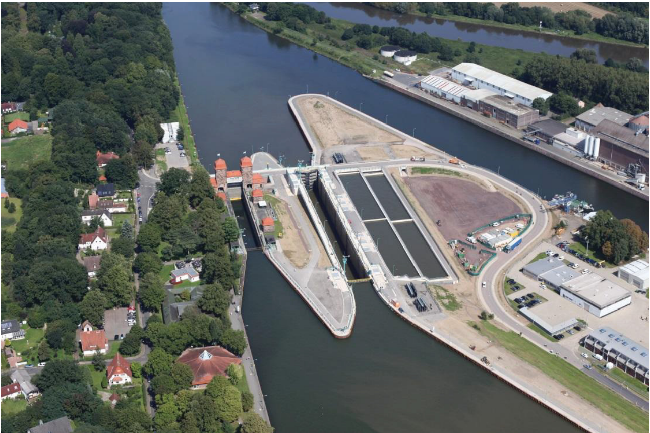
Bild 8: Luftbild der neuen Weserschleuse Minden.
