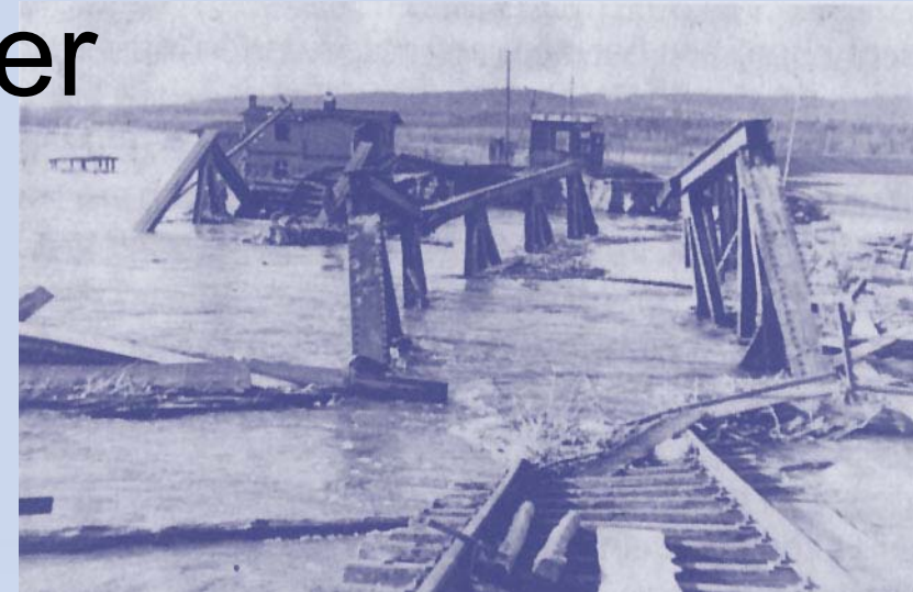
1947: Eisenbahnbrücke bei Schiffmühle
