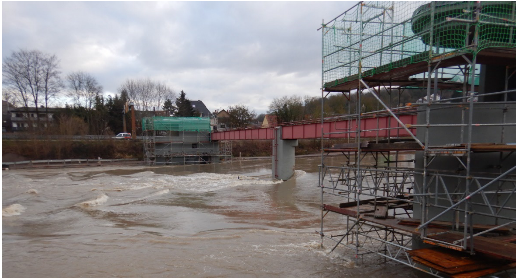
Abbildung 6: Wehr Gündingen, Hochwasser
