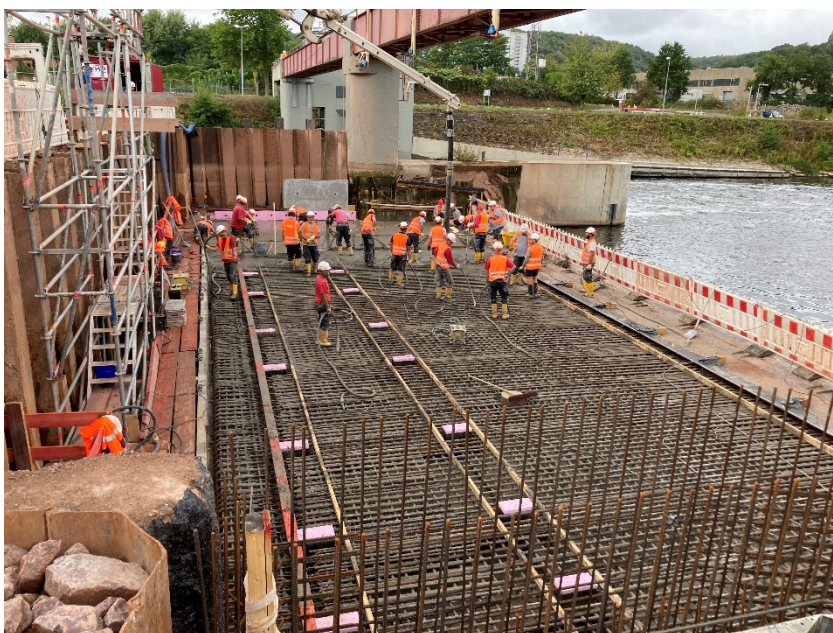
Abbildung 7: Wehr Gündingen, Betonage Sohle 2022
