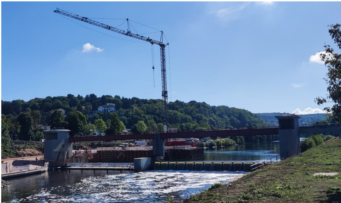
Abbildung 2: Heutiger Zustand Wehranlage Güdingen
