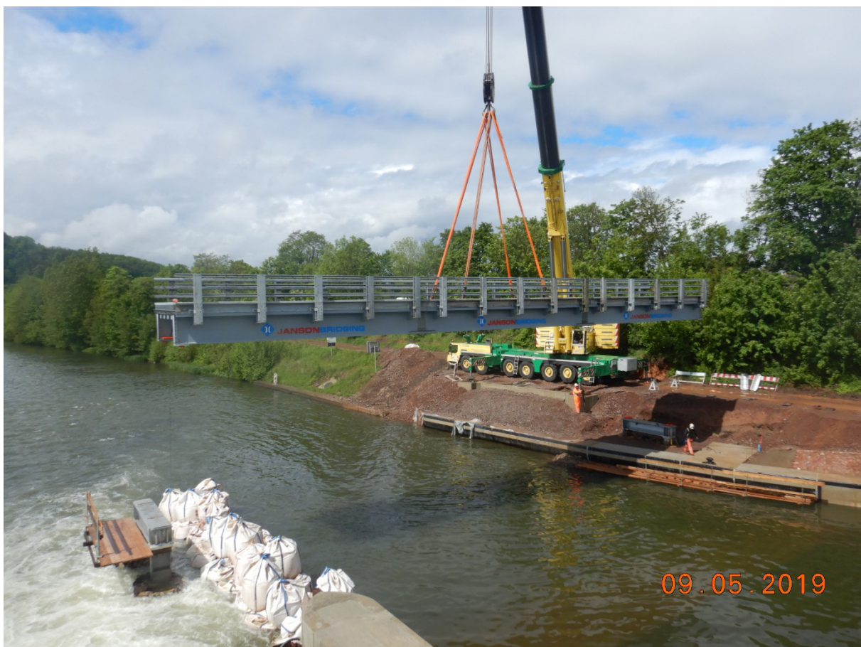
Abbildung 5: Wehr Gündingen, Behelfsbrücke 2019
