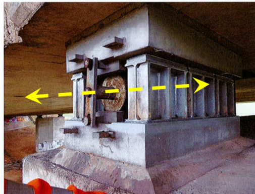
Abb. 5: Teilweise aufgespaltetes Edelstahlrollenlager (links) mit temporärer seitlicher Hilfsabfangung (rechts) einer Brücke mit Baujahr 1975
