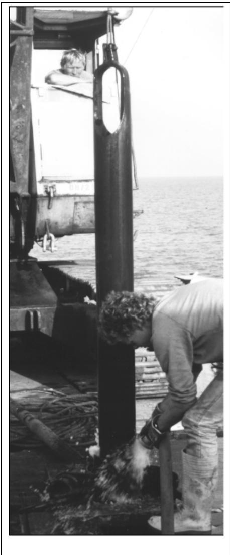
**Bild 17:** Ventilbohrer unter Wasserzugabe ziehen
