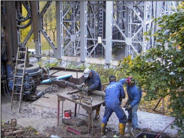
**Bild 31:** Bearbeitung eines Rammkerns nach der Entnahme
