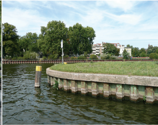
Bild 3: Mit Spundwand gesichertes Ufer, das keinen pflanzlichen Bewuchs ermöglicht (Foto: Liebenstein, BfG)
