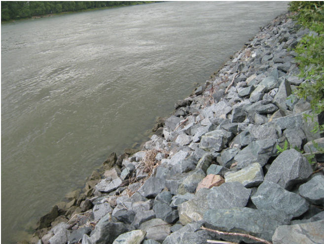
Bild 2: Mit Schüttsteinen gesichertes Ufer am Rhein, das überwiegend frei von pflanzlichem Bewuchs ist (Foto: Eisenmann, BAW)
