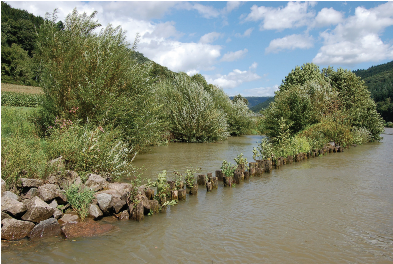
Bild 5: Ein durch Pfahlbauweise geschützter Uferbereich am Neckar flussaufwärts von Neckarsteinach (Foto: Herz, BfG)
