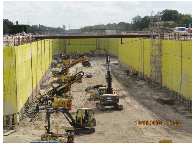
Bild 7: Ankerarbeiten B-Lage
