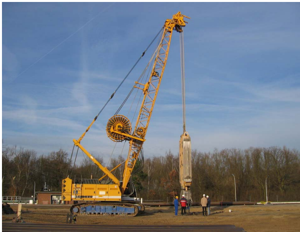
Bild 6: Dichtwandgreifer
