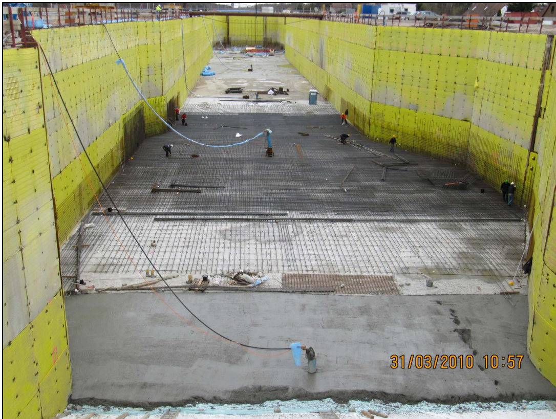
Bild 8: Blick in die fertig gestellte Baugrube
