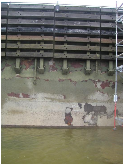
Bild 1a und 1 b: Beispiele des Korrosionsschutzzustandes der Troginnenseite (Ilmenau Nord, 2013)
