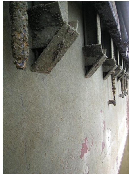
Bild 1a und 1 b: Beispiele des Korrosionsschutzzustandes der Troginnenseite (Ilmenau Nord, 2013)
