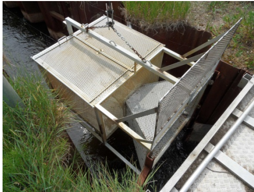
Abb. 3: Reuse im gehobenen Zustand (Foto: Mockenhaupt, BfG)
