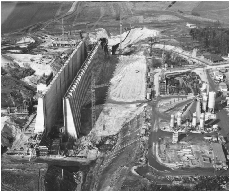
Bild 1: Bau der Schleuse Uelzen I
