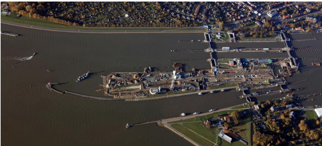
Bild 1: Luftbild der Schleusen Brunsbüttel (WSA Brunsbüttel)
