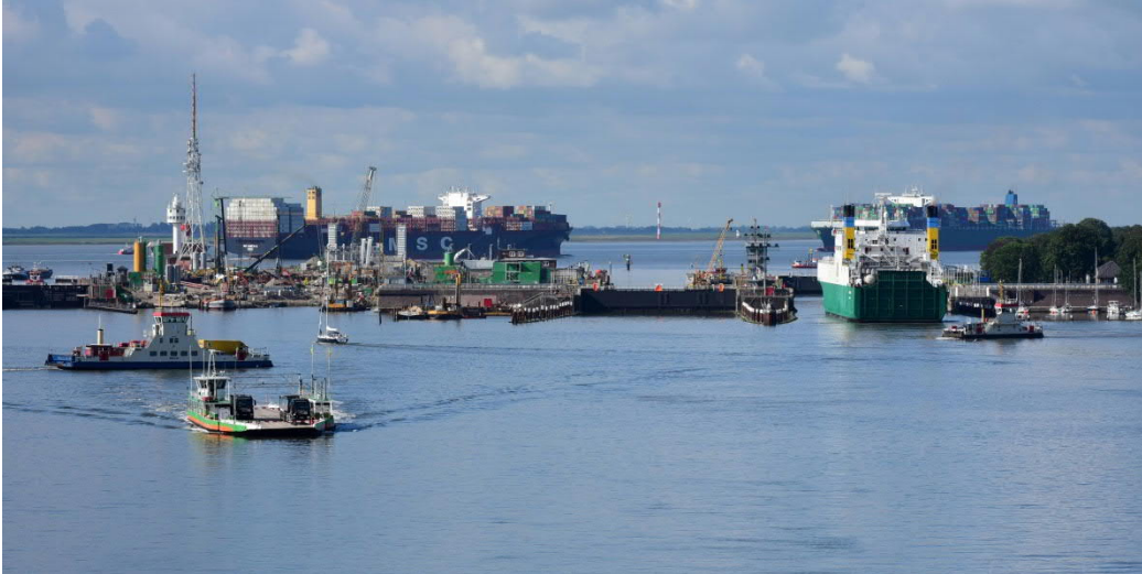
Bild 3: Schleuse und Baustelle (GDWS Kiel)
