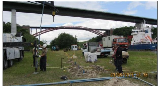
**Bild 6:** Endlosschnecke, im Hintergrund verrohrte Trockenbohrung (Mitte) und Drucksondierung (rechts), Levensauer Hochbrücke 2015
