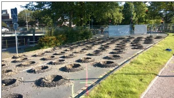
**Bild 1:** Bohrungen für eine Kampfmittelerkundung (Foto: Fichtner Water + Transportation GmbH, Hamburg)
