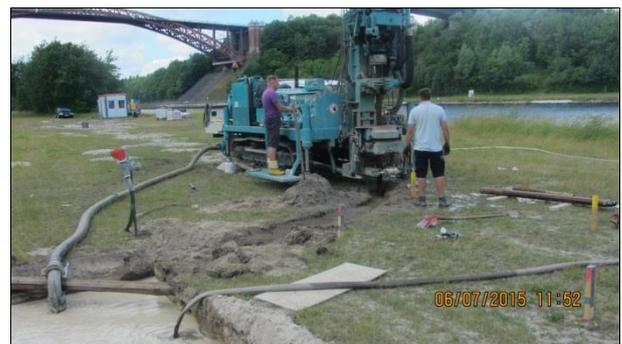
**Bild 7:** Spülbohrung, Levensauer Hochbrücke 2015
