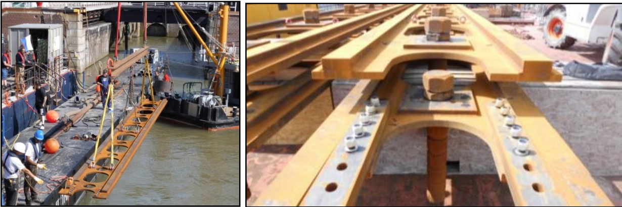
Bild 4: WSA Brunsbüttel (2013), Einbau Bohrschablone und Schienenplatten mit Ankern
