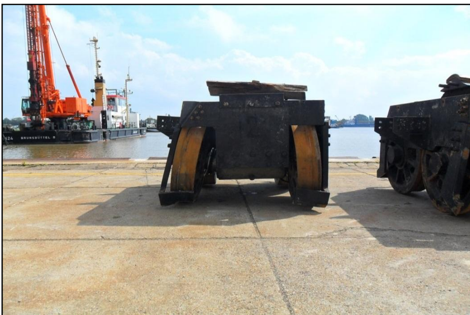
Bild 1: Torunterwagen mit Achsbruch (WSA Brunsbüttel, 2011)
