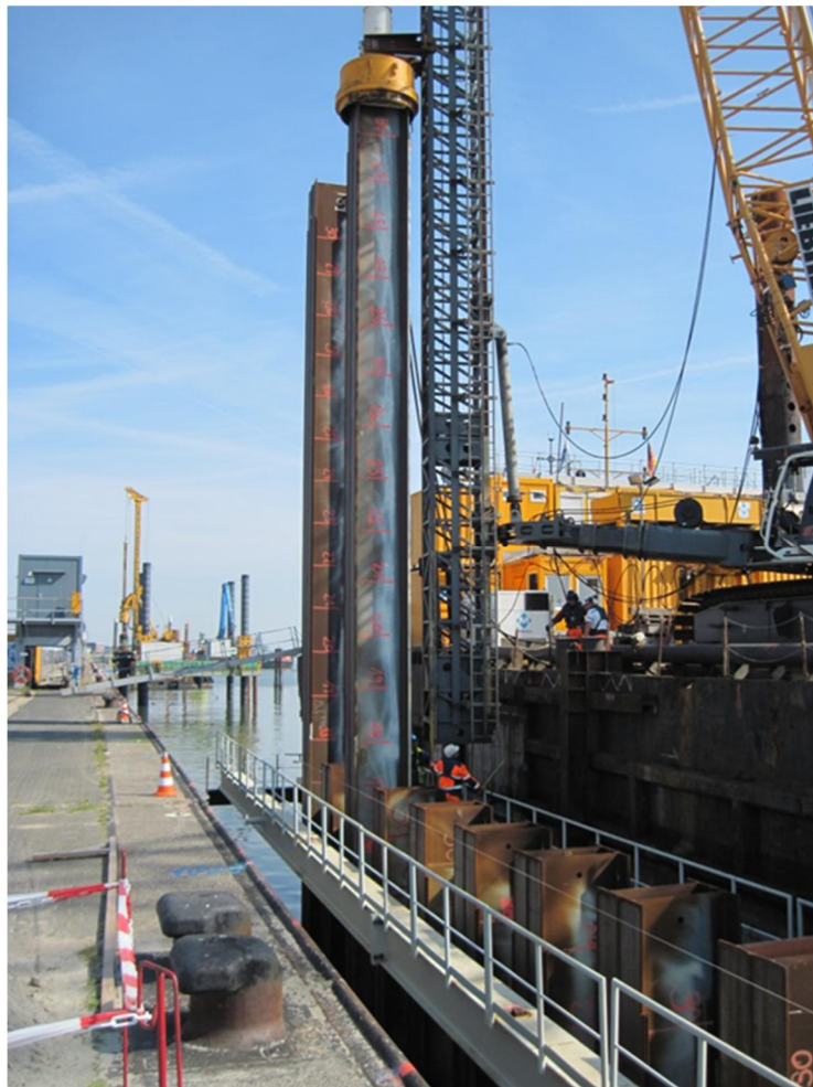
Bild 11: Rammung der Tragbohlen
