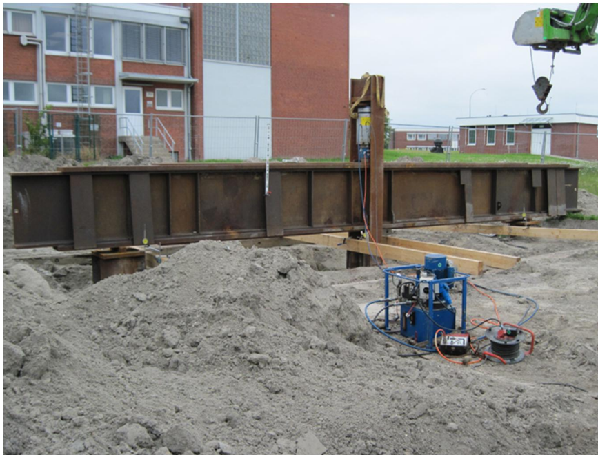
Bild 12: Probelastungsaufbau, Probefeld C
