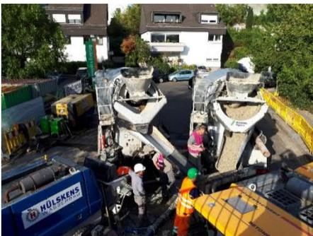
*Bild 7: Frischbetonübergabe in die stationäre Betonpumpe (Quelle: Wayss & Freytag Ingenieurbau AG)*
