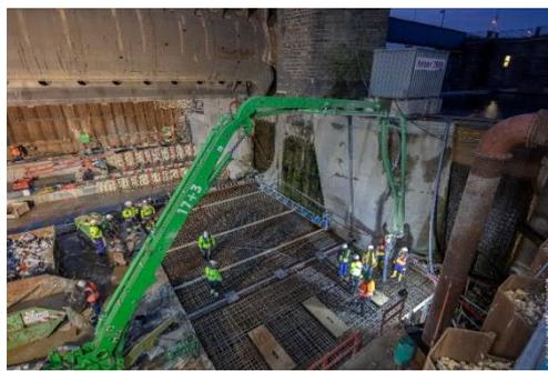
*Bild 8: Betoneinbau Wehrsohle (Quelle: Bundesanstalt für Wasserbau)*
