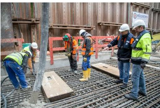
*Bild 9: Betoneinbau Wehrsohle (Quelle: Bundesanstalt für Wasserbau)*
