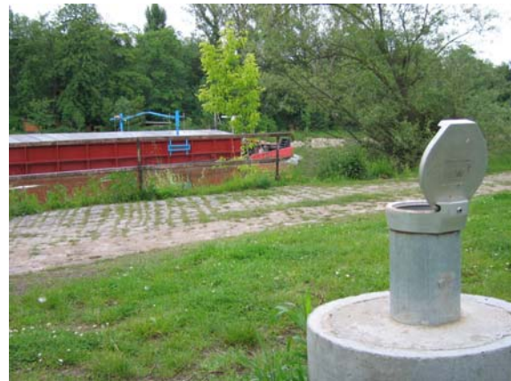
Bild 1: Geöffnete Grundwasser-Messstelle an einer Bundeswasserstraße
