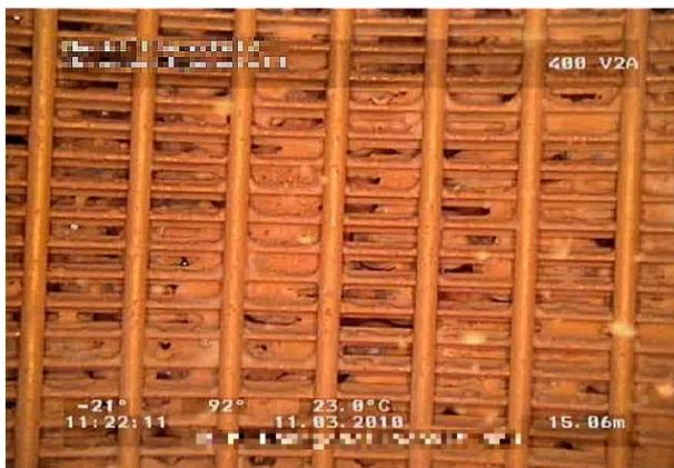
**Bild 3:** Anlagerung von Eisenhydroxiden an Glaskugeln und in den Schlitzen in einem Wickeldrahtfilterbrunnen. Foto: Fa. Ochs, Nürnberg
