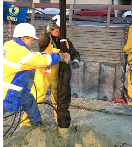
Ankereinsatz (Gewebeslauchpacker)
