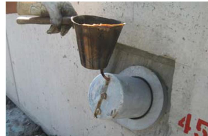
Ankerschutzhaube mit Korrosionsschutzmasse verfüllen
