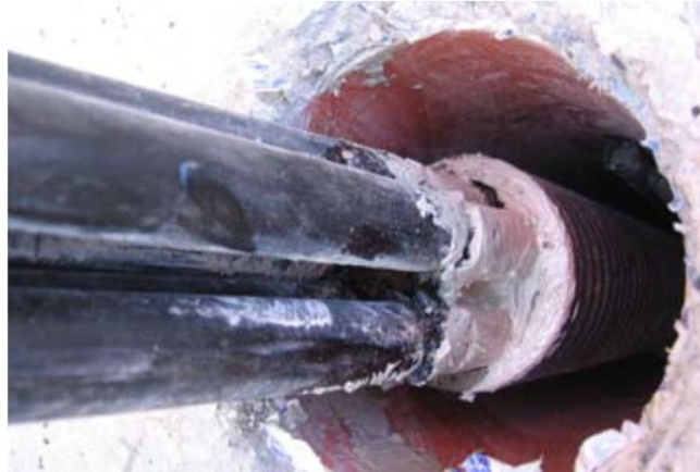
Beschichtung Zementstein- oberfläche (Ausölschutz)
