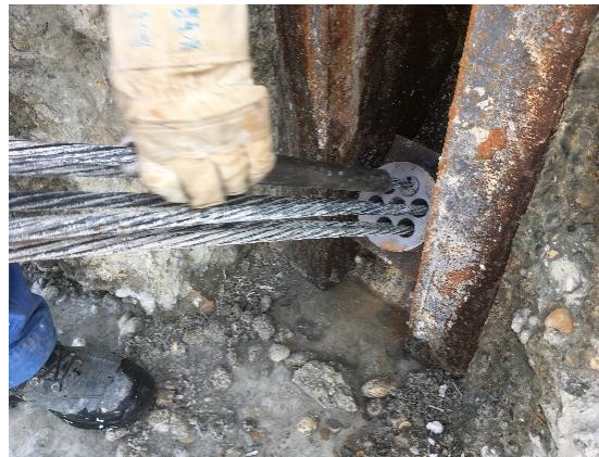
Fixieren der Klemmkeile
