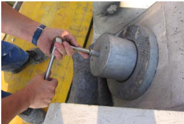
Montage Gummidichtscheibe und Ankerschutzhaube
