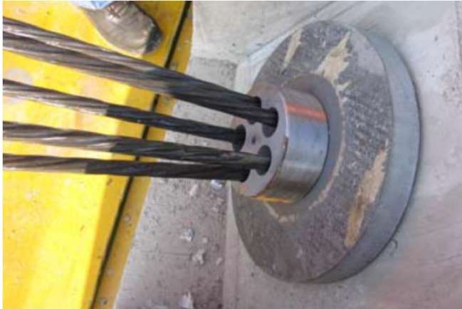
Keilträger montieren, Graphitspray
