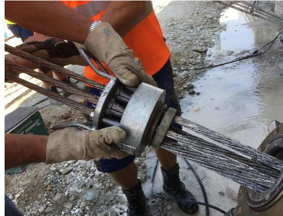
Aufsetzen des Endverkeilers
