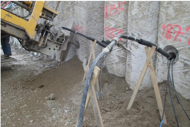
Innere Verfüllung des Wellrohrs (VOR der Primärverpressung)
