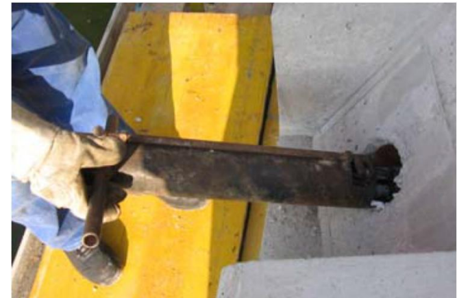
Wellrohr entfernen mit Rohrabschneider
