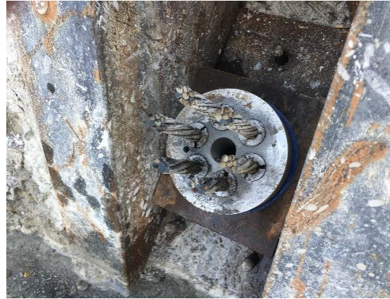
Gekürzte Spannstahllitzen
