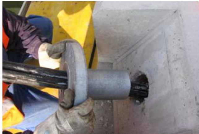
Positionierung Ankerplatte mit Stahlüberschubrohr
