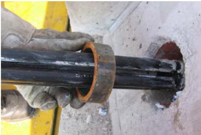
Positionierung Umlenkring
