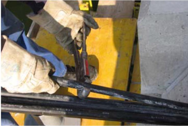
Hüllrohre entfernen
