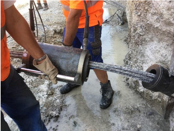
Aufsetzen der Spannpresse
