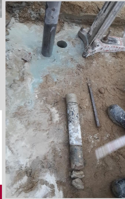
Sohlplatte einer Müllverladestation mit bewehrten Streifenfundament
