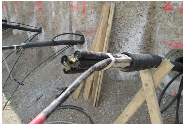
Hier: mit Korrosionsschutzmasse gefüllte PE-Hüllrohre
