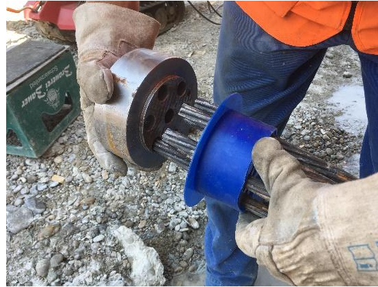
Keilträger und Dichttopf
