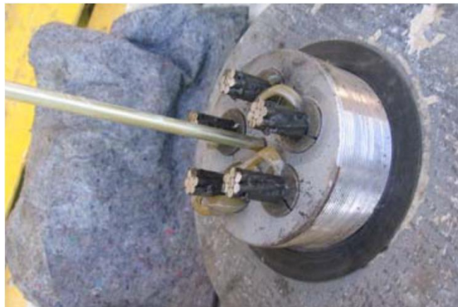
Litzen kürzen, Verfüllung mit Korrosionsschutzmasse
