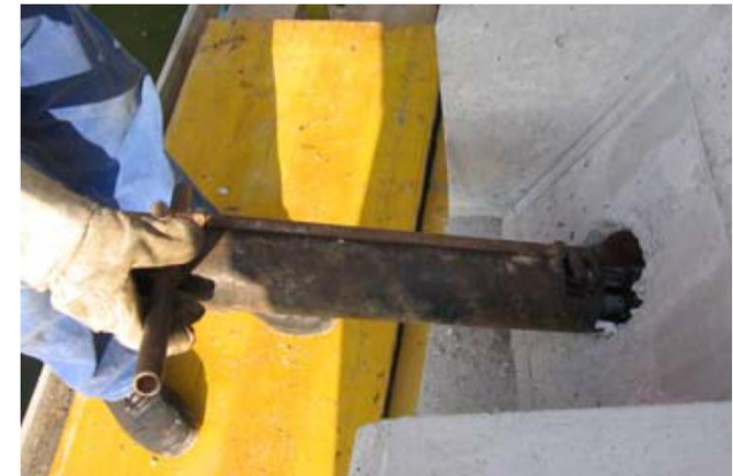
Wellrohr entfernen mit Rohrabschneider
