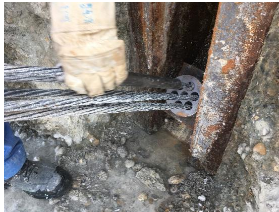
Fixieren der Klemmkeile
