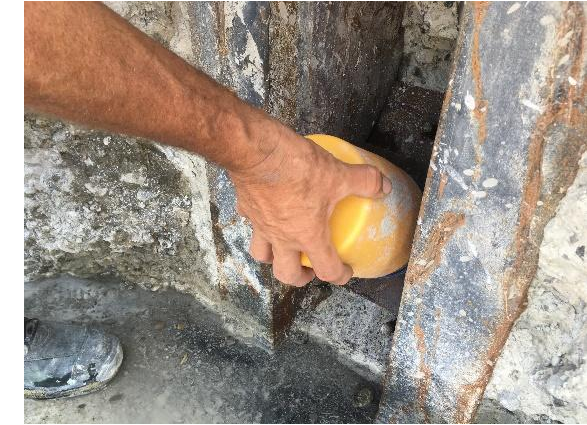
Montage der Ankerkappe
