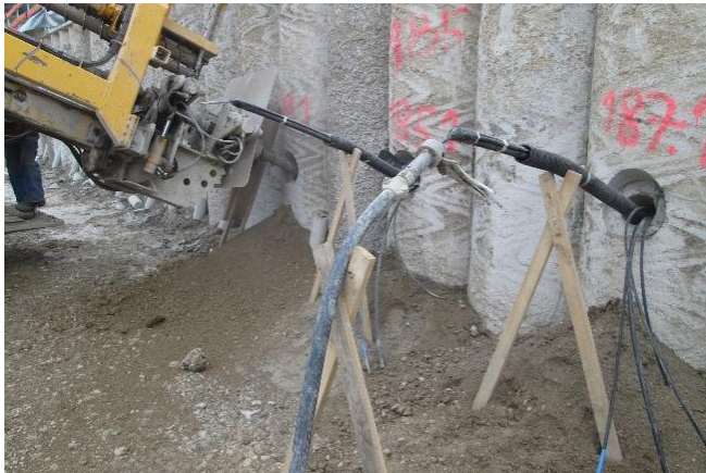
Innere Verfüllung des Wellrohrs (VOR der Primärverpressung)
