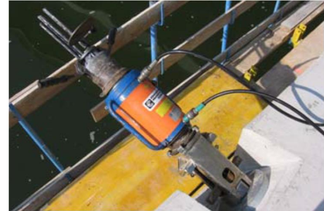
Prüfen, Spannen und Festlegen
