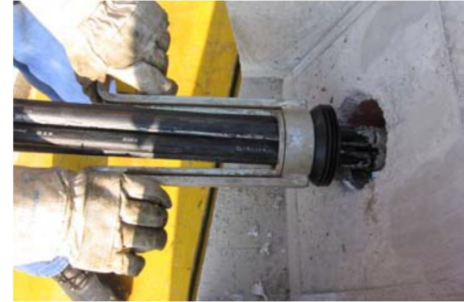
Positionierung Dichtlamelle
