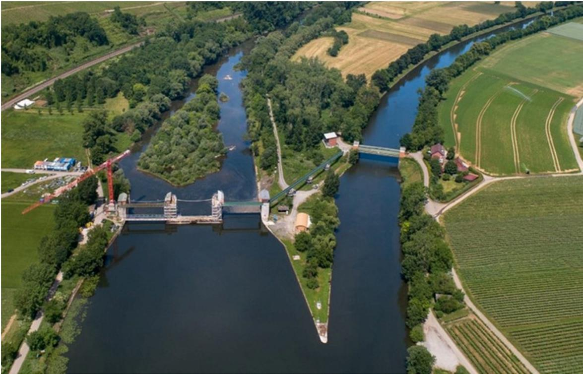
*Abbildung 2: Grundinstandsetzung des Wehres Horkheim mit zugehörigem, neu errichteten Technikgebäude auf dem linken Ufer des Seitenkanals, Stand 2022 [Foto: WNA Heidelberg]*
