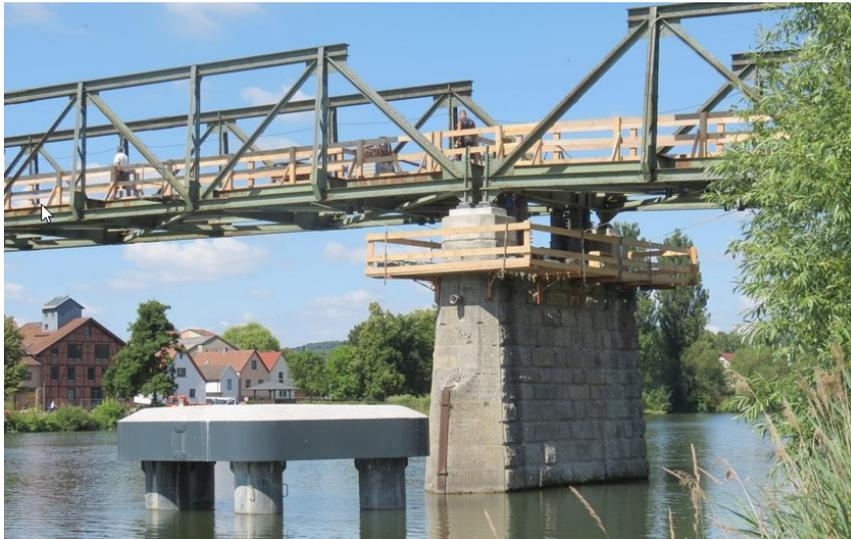
Abbildung 7: Schutzbauwerk kurz nach Fertigstellung © Büchting+Streit AG
