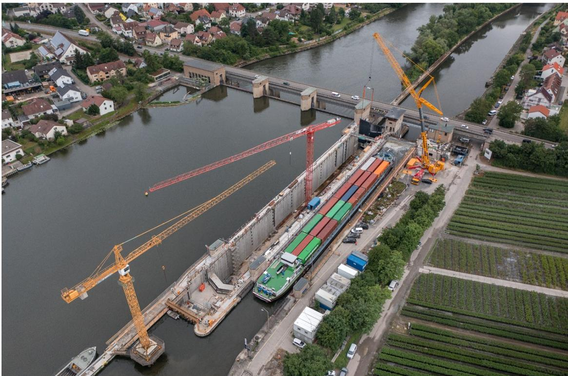
Abbildung 5: Linke Schleusenammer Lauffen - Einbau der jeweils 44 Tonnen schweren Stemmtorflügel des Untertores [Foto: WNA Heidelberg]
