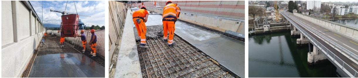
Abbildung 8: UHFB-Einbau auf der bestehenden Brückenplatte zur Instandsetzung und Verstärkung der Brückenplatte. Foto rechts: Ansicht nach Abschluss der Arbeiten (Fotos: B+S AG, Consulting Engineers, Bern, Schweiz).
