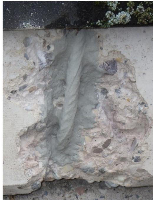
*Abbildung 2: Instandsetzung freiliegender Bewehrung an Maschinenhallendecke*
