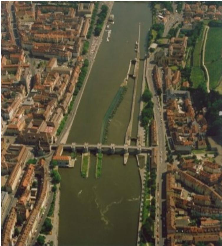
*Abbildung 8: Staustufe Würzburg von Unterwasser aus gesehen (von links nach rechts: Wasserkraftanlage, 2-feldriges bewegliches Wehr, Streichwehr, Boots- und Großschifffahrtsschleuse) [Foto: WSV]*
