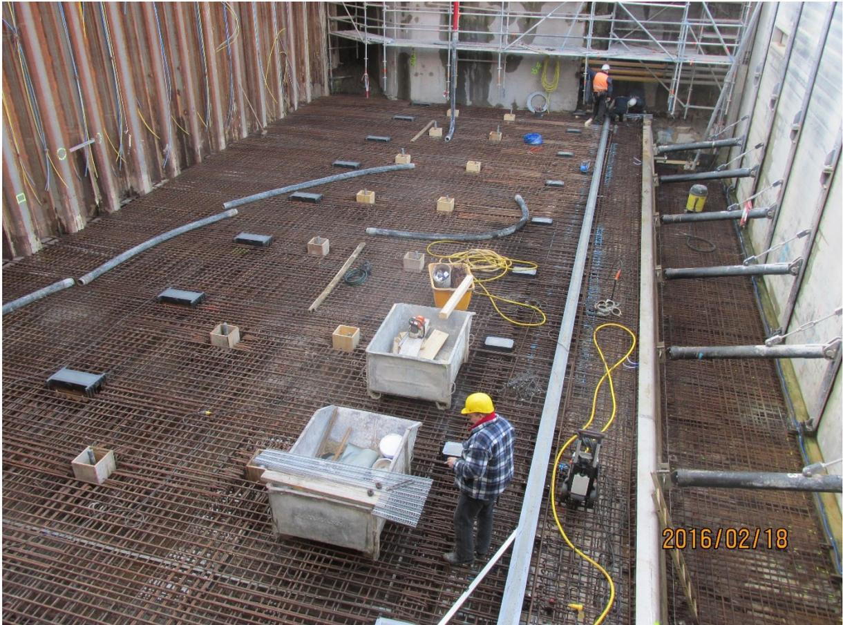
Abbildung 3: Bewehrungsarbeiten mit eingebauten Verpressankern in der Sohle des Wehres Horkheim [Foto: WNA Heidelberg]
