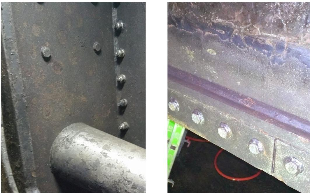
*Abbildung 5: Abgeschlossene Untergrundvorbereitung nach Handentrostung*
