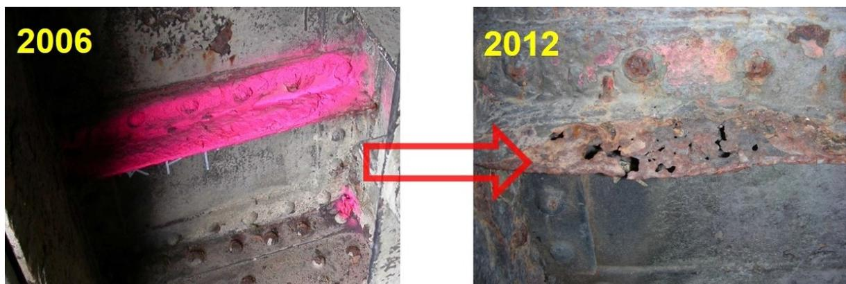
Abbildung 4: Entwicklung eines unbehandelten Korrosionsschadens innerhalb eines Prüfmittels
