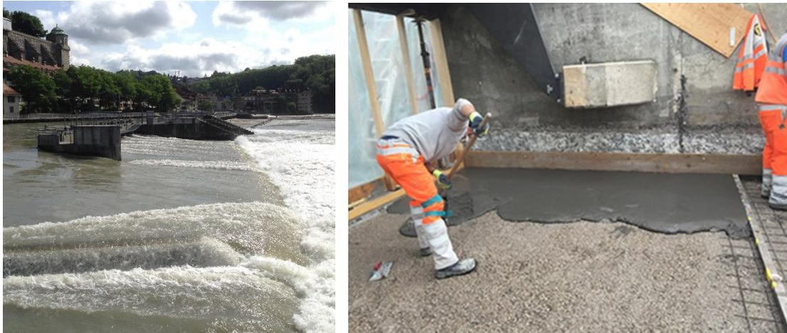
Abbildung 5: „Matteschwelle“ nach dem Einbau der UHFB-Schutzschicht auf vorbereitetem Betonuntergrund der Schwelle (Foto rechts: Holcim Schweiz).
