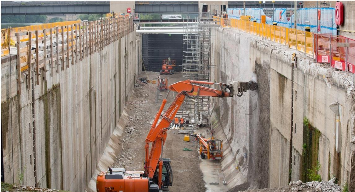
Abbildung 4: Linke Schleusenammer Lauffen – Fräsarbeiten [Foto: WNA Heidelberg]
