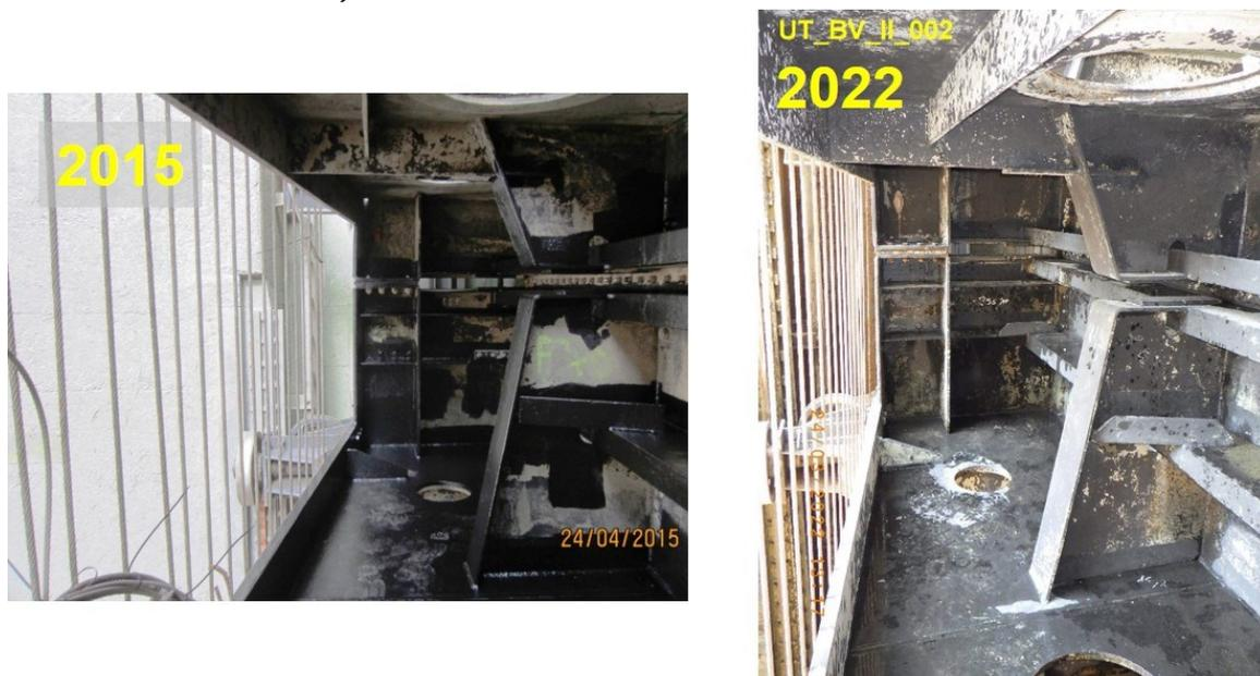
Abbildung 7: „Smart-Repair“-Maßnahme Untertor – Zustand bei Ausführung und nach 7 Jahren
