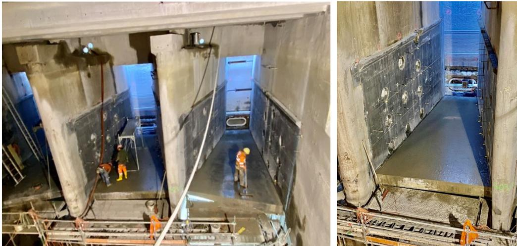
Abbildung 6: UHFB-Schutzbeschichtung (in dunkelgrau) auf der Bodenplatte und den Seitenwandflächen der Auslasskammern des Turbinenhauses.
