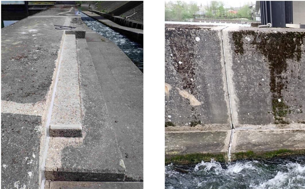
Abbildung 3: Erneuerung bzw. Abdichtung von Bauwerksfugen an Fischaufstiegsanlage
