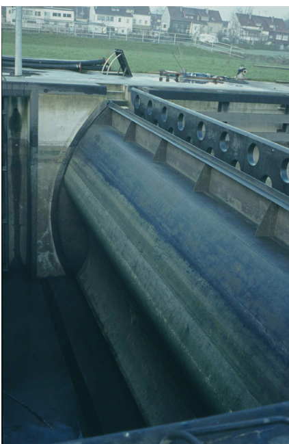
Bild 5 a und b: Drucksegmenttor der Saarschleuse Lisdorf
