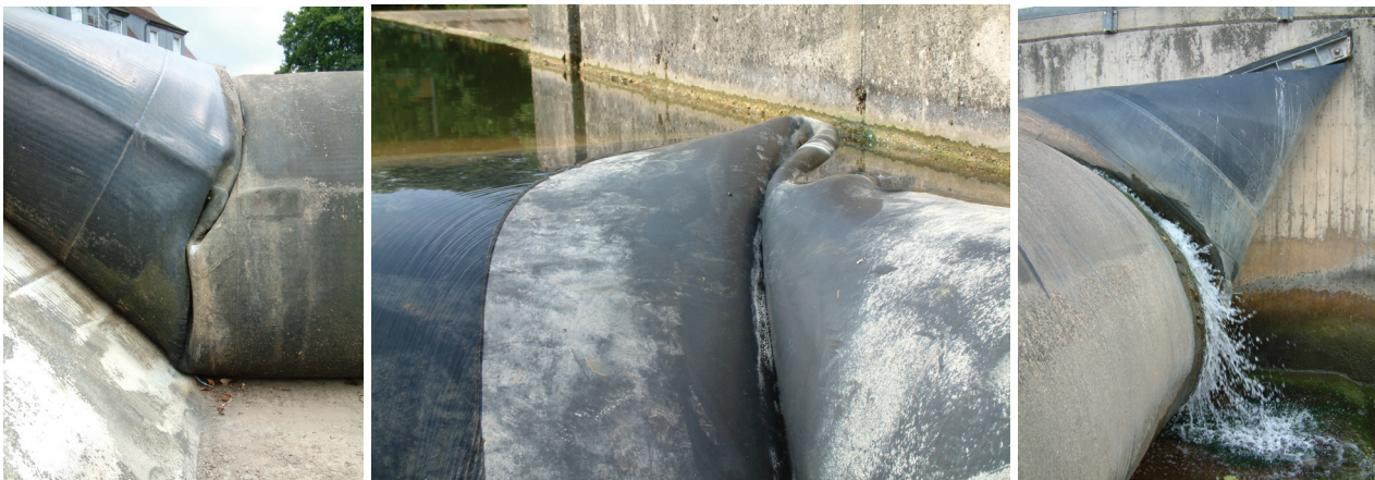
Bild 5: Unterschiedliche Faltenbildung bei wassergefüllten Schlauchwehren
