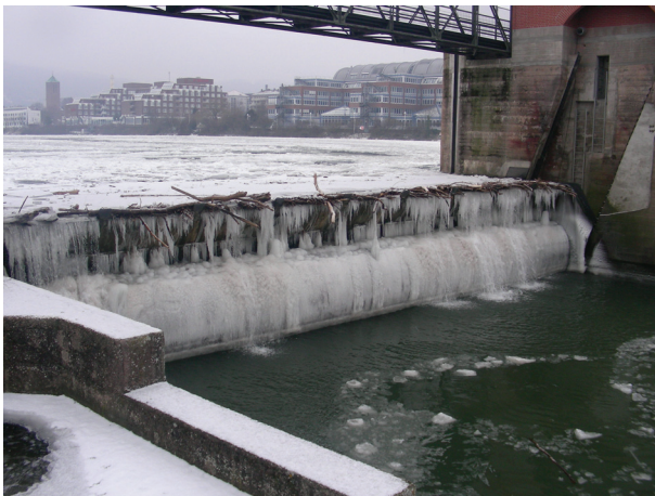
Bild 1: Eisbildung auf einem Verschluss
