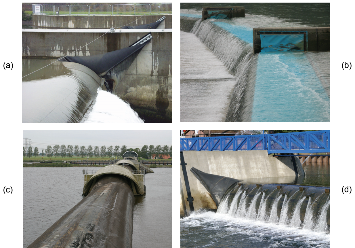
Bild 1: Verschiedene Befestigungssysteme: (a) Luftfüllung mit senkrechten Wehrwangen, (b) Wasserfüllung mit senkrechten Wehrwangen, (c) Wasser- und Luftfüllung mit geneigten Wehrwangen und (d) Wasserfüllung mit geneigten Wehrwangen
