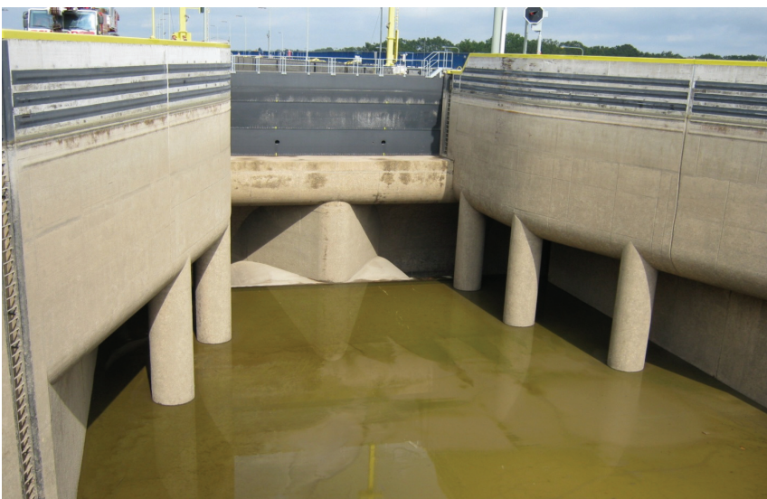
Bild 2: Schleusenoberhaupt mit hochleistungsfähigem Einlauftrichter
