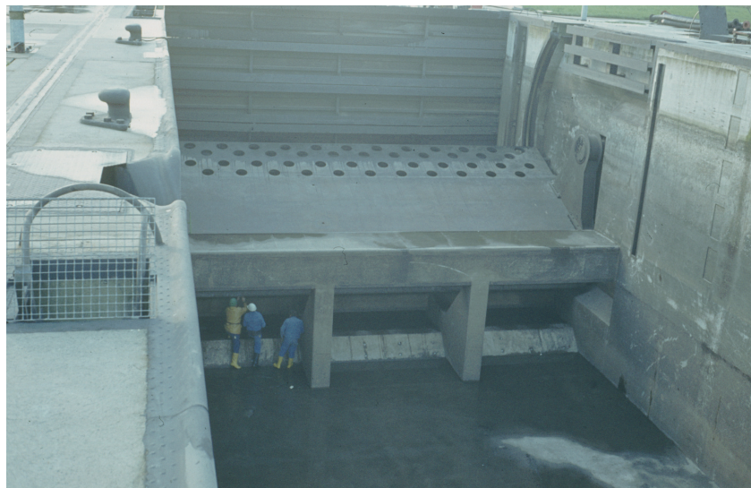
Bild 5 a und b: Drucksegmenttor der Saarschleuse Lisdorf
