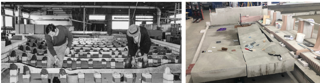
Abbildungen 9 und 10: Links Aufbau eines Flächenmodells 1973, rechts Fräselemente eines Schleusenmodells 2020, beides in der BAW in Karlsruhe (Quellen: links HB14070, rechts BAW)
