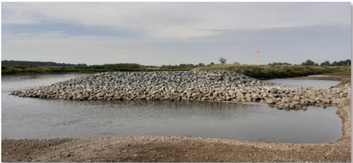
Abbildung 5: ökologische Optimierung von Stromregelungsbauwerken
