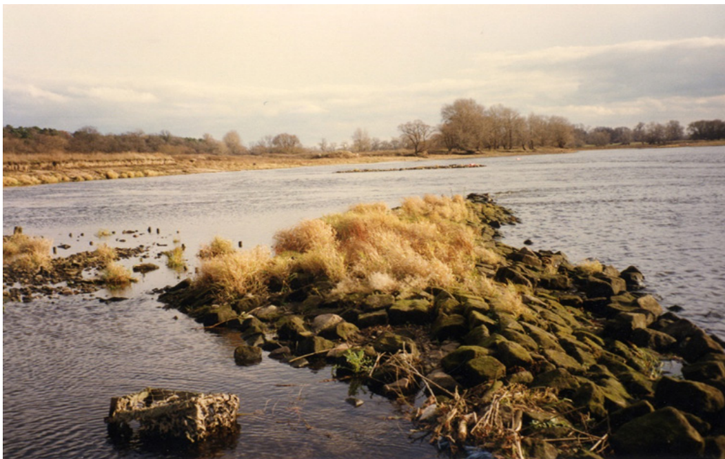
Abbildung 1: Blick von Elbe-km 252,4 bergwärts (1994 WSA Dresden)
