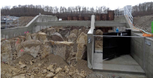
Bild 5: Mit Drehtor regelbares Einlaufbauwerk Verbindungsgewässer KW Ryburg-Schwörstadt
