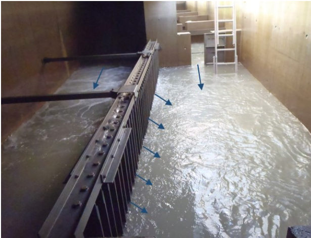
Bild 10: Zugabe Dotierabfluss über verstellbare Lamellenwand am KW Lehen/ Salzach
