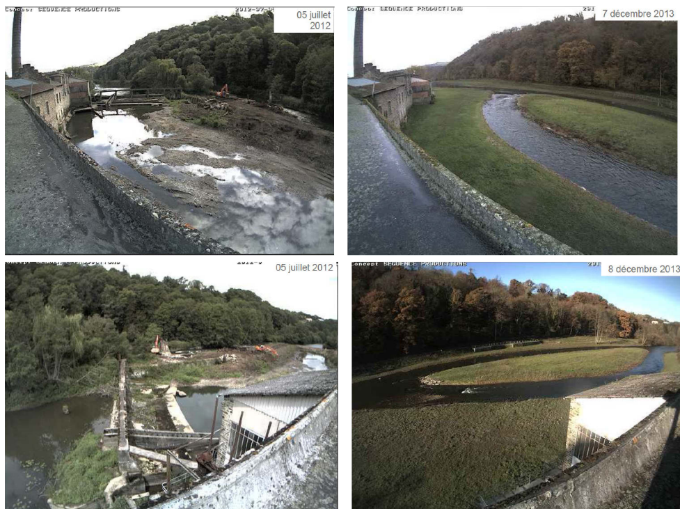
Figure 4: Photographies avant et après effacement de l’ouvrage à partir de prises de vue sur point fixe (AESN Direction des Bocages Normands)
