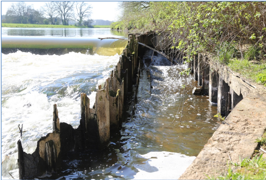
Bild 2: Kulturwehr Geeste (Detail: Abgängige Fischaufstiegsanlage)
