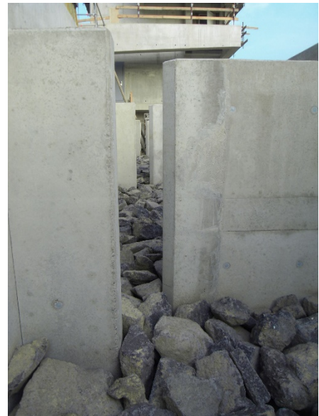
Bild 2: Anpassungsmöglichkeit des Sohlmaterials im Schlitz
