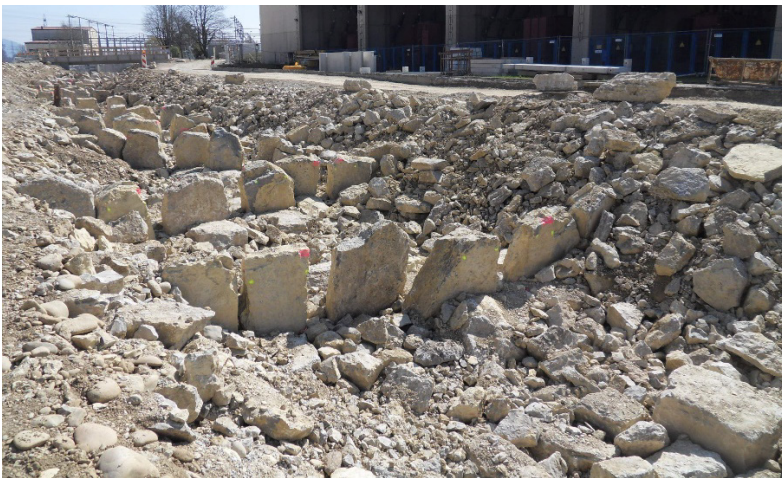
Bild 1: Bei Raugerinnen ist eine nachträgliche Anpassung der Querriegel möglich
