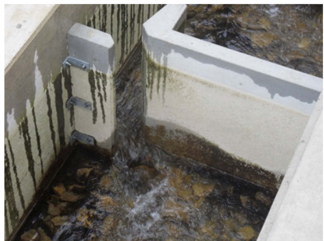
Bild 4: Umlenkblock als Fertigteil, Schlitzweite kann durch Verschieben eingestellt werden.
