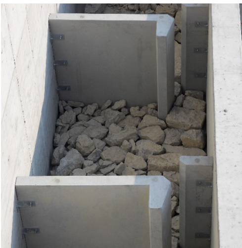
Bild 3: Einbauten aus Fertigteilen Befestigung mit Winkeln
