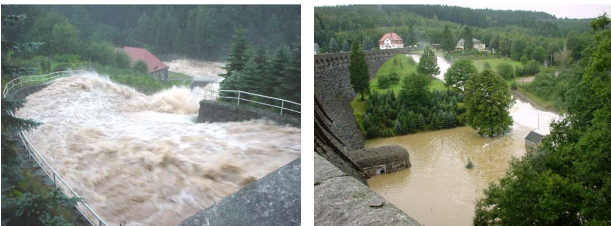
Abbildung 1: Hochwasserentlastungen der TS Malter (links) und TS Klingenberg am 13.08.2002
