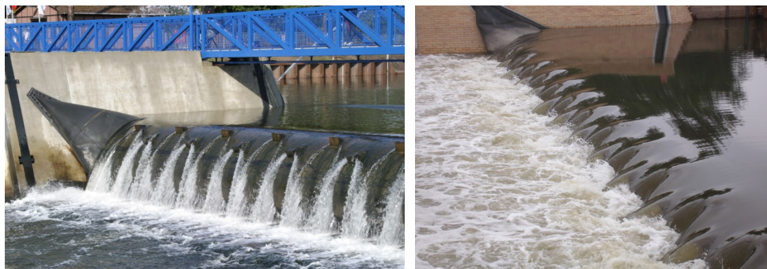
Abb. 1: Überströmtes Schlauchwehr mit geringem (links) und erhöhtem Unterwasserstand (rechts) (Fotos: BAW)
