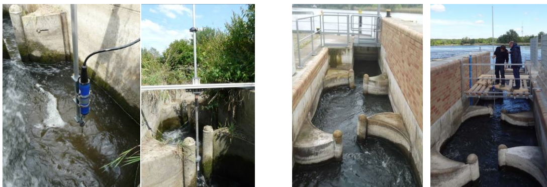
Abb. 3: Links: FAA Rothemühle, 3d-Strömungsmessung im Becken B4 und Schlitz S4, rechts: FAA Bahnitz 1d- und 3d-Strömungsmessung in Becken B3 (Fotos: TU Dresden, IWD)
