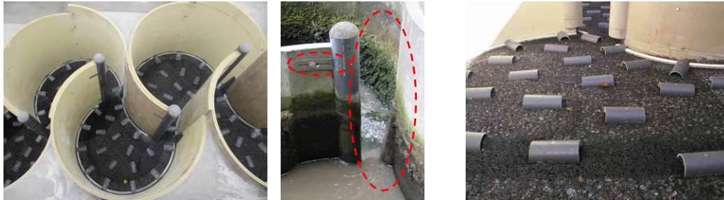
Abb. 1: Links: Anordnung von GfK-Halbrohren bei einem C-Typ, mittig: „Umlenkrohre“ zur Schlitzweitenregulierung, rechts: Sohlaufbau (Peters Ökofisch GmbH & Co. KG, IWD); (Fotos: Peters Ökofisch GmbH & Co. KG)
