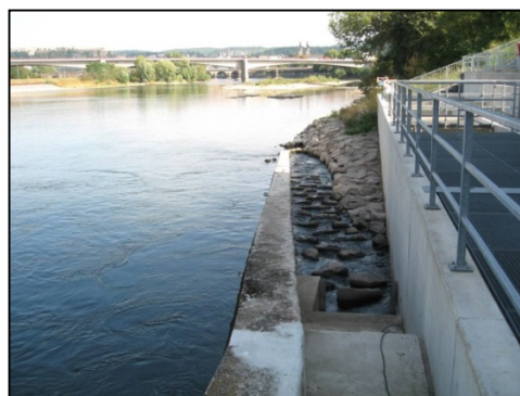
Abb. 4: Typ „C“ – abgerückter Einstieg mit Sohlanbindung
