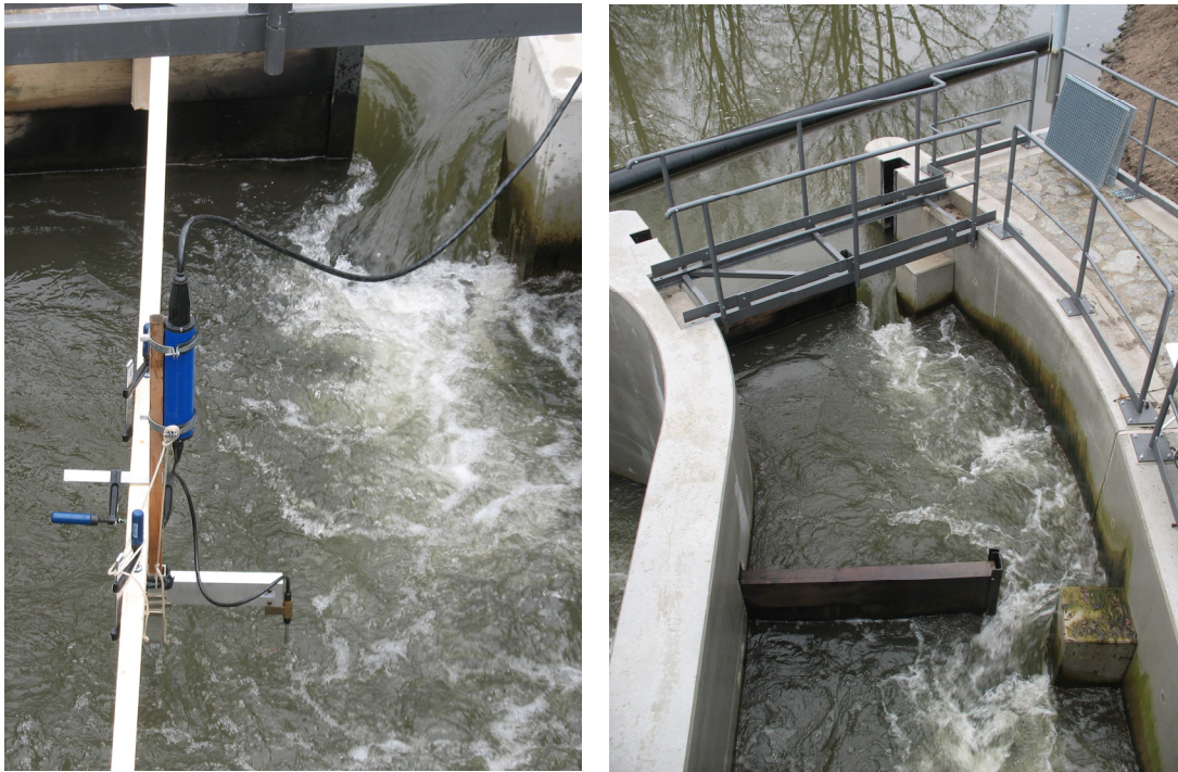
Abb. 1 und 2: Strömungsmessungen am Beispiel einer FAA an der Neiße; unterschiedliche Strömung in verschiedenen Schlitzten (Fotos: Wirtz)
