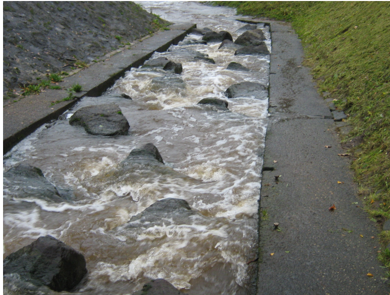
Abb. 5: Die FAA Bollingerfähr/Ems wurde in 2007 u. a. durch den Einbau von Störsteinen optimiert. Am oberwasserseitigen Ende der FAA war die Fangeinrichtung (Netzwall und Fangkammer) installiert.
