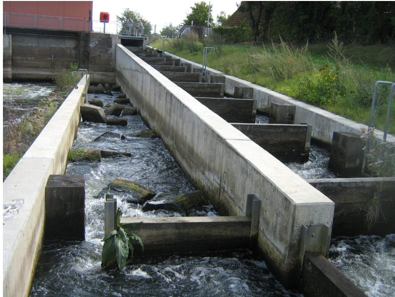
Abb. 7: Die Fischaufstiegsanlage Marklendorf mündet direkt neben der Ausleitung der Wasserkraftanlage. Durch Zuleitung eines Bypasses zwischen der Ausleitung der uferseitigen Turbine und dem Mündungsbereich der FAA wird deren Leitströmung erhöht.
