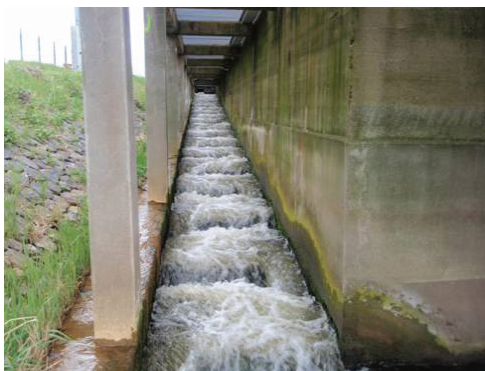
Abb 7/8: Bestehender Beckenpass Staustufe Eddersheim, WNA Aschaffenburg 04/2012
