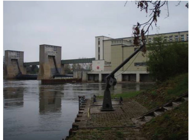
Abb 6: Kraftwerksauslauf mit Krananlage, WNA Aschaffenburg 03/2012
