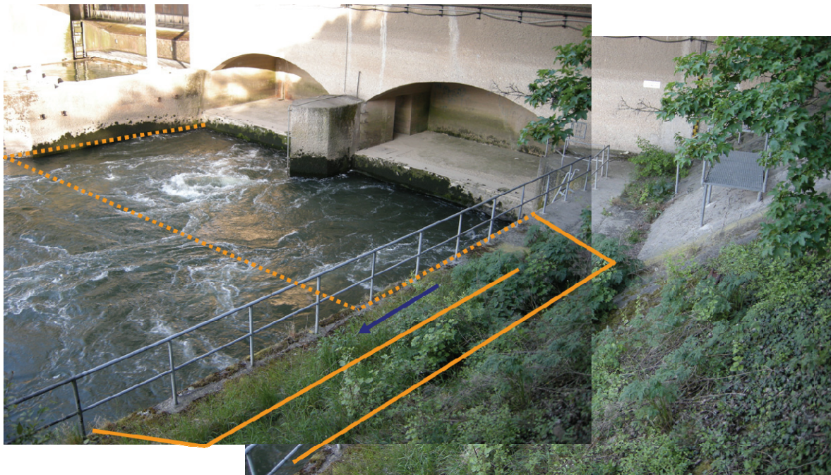
Bild 2: Unterwasserbereich der Wasserkraftanlage Lauffen/Neckar mit turbulenter Ausströmung der Saugrohre. Die mögliche Verlängerung des Saugrohrs (gestrichelt) und die künftige Position des Einstiegs sind eingezeichnet
