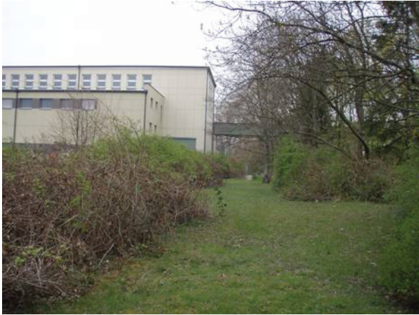
Abb 5: Raumsituation Schleuseninsel Eddersheim, WNA Aschaffenburg 03/2012
