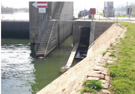
Abb. 15 Bestehender Beckenpass, Staustufe Wallstadt, WNA Aschaffenburg 06/2011
