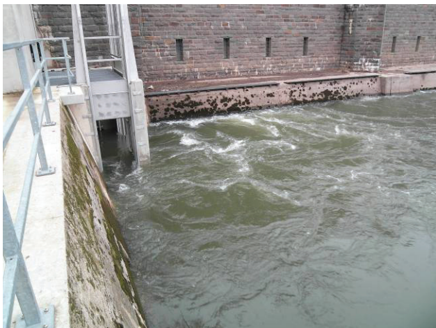
Bild 12: Zwei Mündungen im UW des Krafthauses
