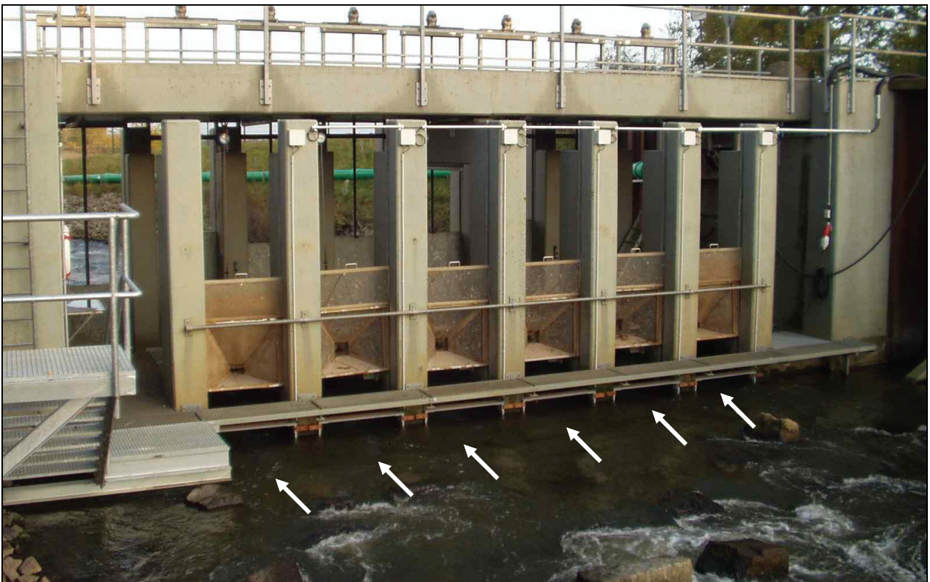
Bild 6: Im Umgehungsgerinne am Südufer sind 6 Rahmenantennen von jeweils 1 m x 1 m Größe in einer Reihe unter der ehemaligen Kontrollstation installiert
