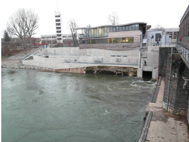
Bild 10: FWA Koblenz, Gesamtansicht
