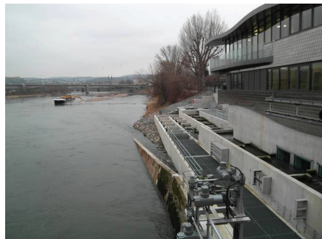
Bild 13: Dritter Mündungsarm (Sohlanschluss)
