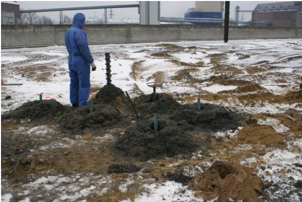
Bild 10: Bohrungen für eine Tiefensondierung Quelle iwB 2011
