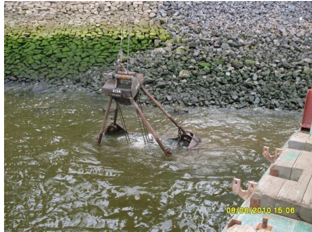
Bild 12: Deckwerksräumung mit Seilgreifer Quelle G.E.O. Monitoring 2010
