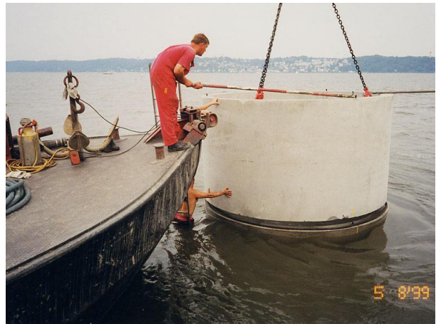
Bild 13: Einsatz eines Spezialverbaues für die Gewässersondierung Quelle Fa, Hirdes 1999
