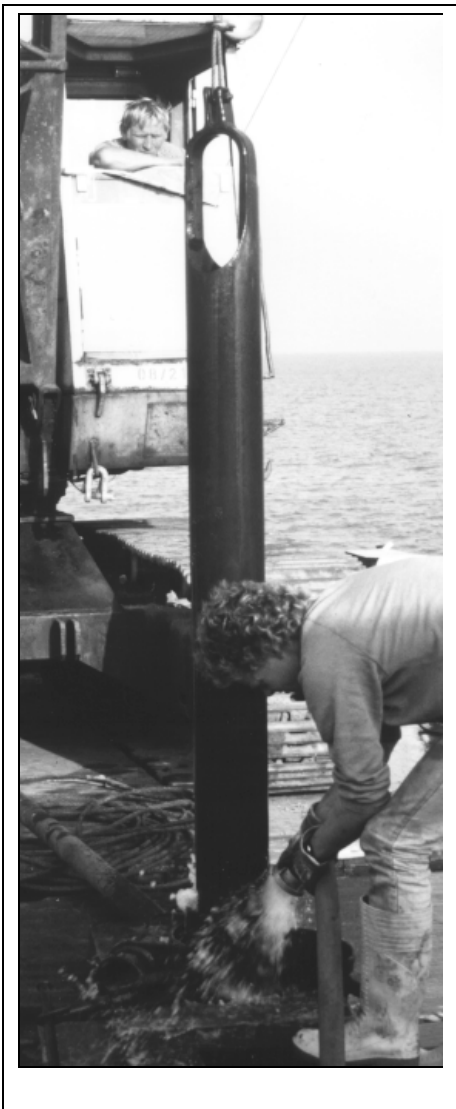
Bild 17: Ventilbohrer unter Wasserzugabe ziehen
