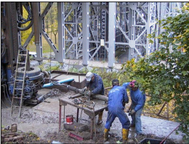
Bild 31: Bearbeitung eines Rammkerns nach der Entnahme
