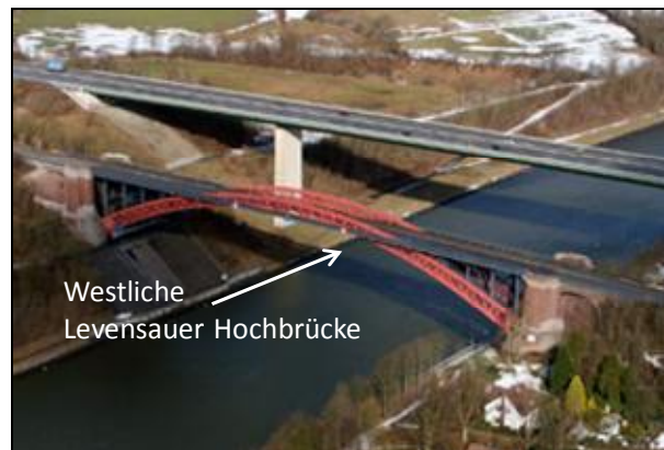
Bild 2: Die Levensauer Hochbrücken am NOK (Foto: www.portalnok.de )
