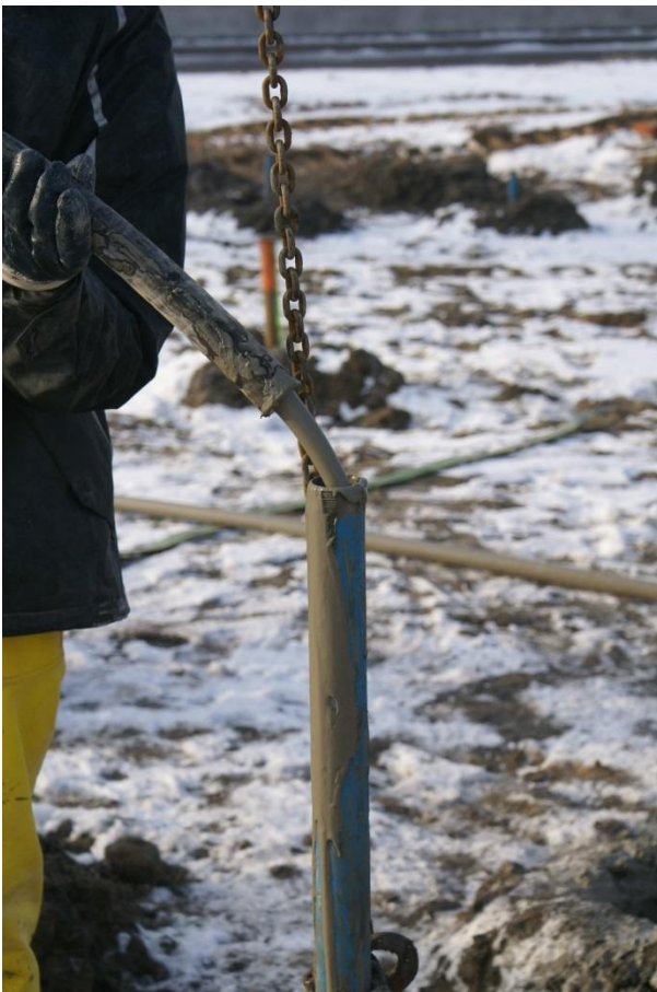
Bild 11: Bohrlochverfüllung mittels Schlauch Quelle iwB 2011
