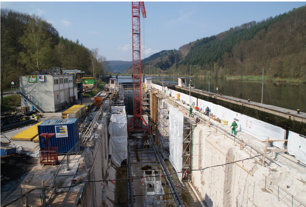
Bild 3: Grundinstandsetzung der rechten Kammer der Schleuse Guttenbach 2009 - 2011
