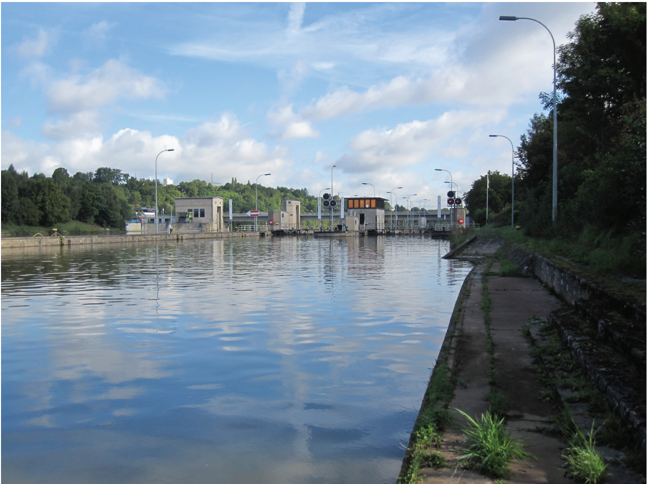
Bild 3: Schleuse Aldingen Oberwasser
