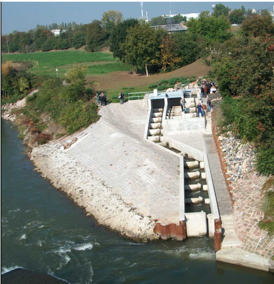
Bild 4: Schlitzpass am Wehr Ladenburg
