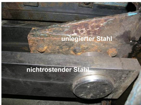
*Bild 6: Korrosion am unlegierten Stahl infolge des nichtrostenden Bolzen und der nichtrostenden Zahnstangen*
