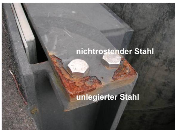
*Bild 5: Korrosion am unlegierten Stahl infolge von nichtrostenden Schrauben*
