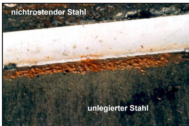
Bild 3: Beschichtungs- und Korrosionsschaden an einer Stauklappe
