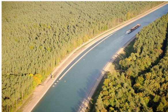
Luftaufnahme 2014 (Quelle: WSA Oder-Havel)
