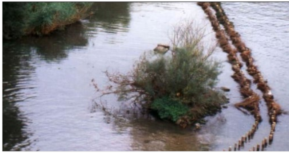
Einbau der Faschinen, bestehend aus Reisigbündeln, in die Doppelpfahlreihe 08/1997 (Quelle: Stadt Eberbach)
