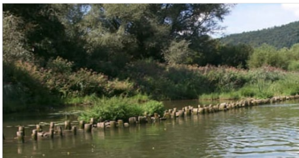
Setzungen der Schüttsteine und der Faschinen in der Doppelpfahlreihe (Unterhaltung) 07/2003 (Quelle: Stadt Eberbach)
