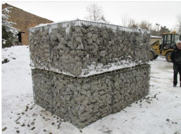
Musterhaft aufgebauter Gabionenblock aus 6 Gabionenkisten 03/2013 (Quelle: WSA Oder-Havel)
