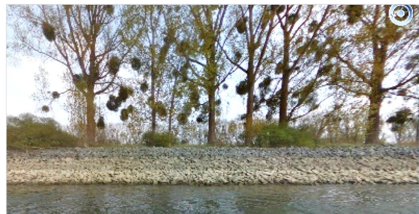
Zustand vor der Baumaßnahme 2016 (Quelle: WSA Oberrhein)
