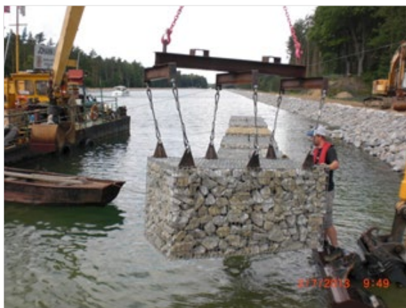
Absetzen einer Gabionenkiste im Wasser 07/2013 (Quelle: WSA Havel-Oder)
