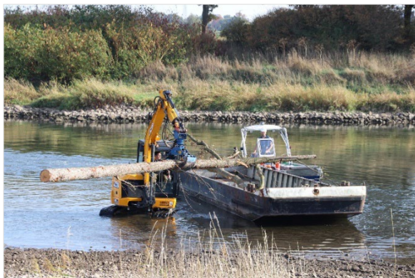
Totholzeinbau 11/2018 (Quelle: WSA Weser)
