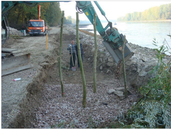
Einbau der Setzstangen in die Steinschüttung 2018 (Quelle: WSA Oberrhein, Neubert)
