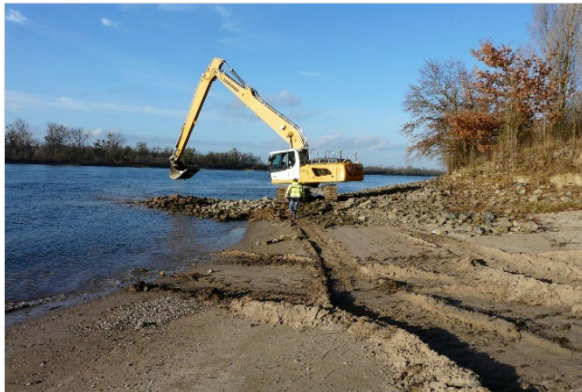
Entnahme der Wasserbausteine mit Langarmbagger 2019 (Quelle: WSA Oberrhein)
