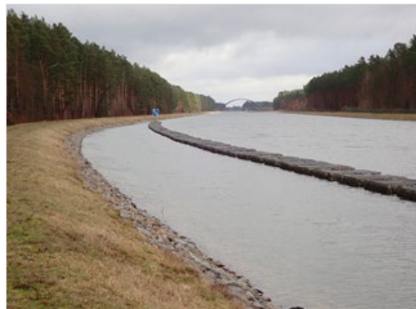
Fertige Gabionenreihe ohne zusätzliche Substrateinfüllung in Flachwasserzone nach 10 Jahren 02/2023 (Quelle: WSA Oder-Havel)
