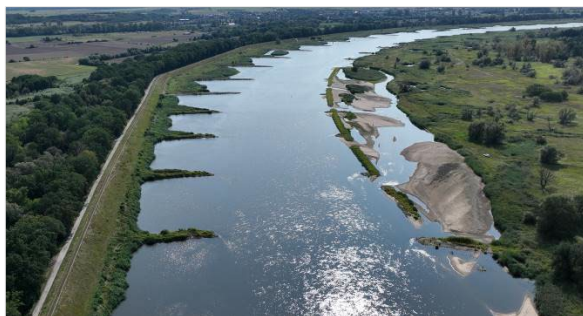
Parallelwerk Reitwein, Wasserstand: leicht über Mittelniedrigwasser 23.08.2024 (Quelle: WSA Oder-Havel)
