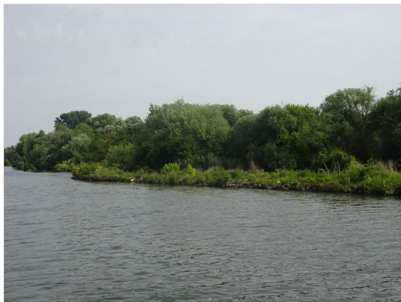
Parallelwerk im Jahr 2025 (Quelle: WNA Aschaffenburg)
