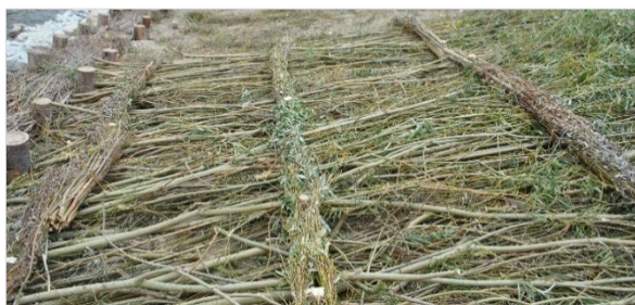
Einbau der Faschinen, bestehend aus Reisigbündeln, in die Doppelpfahlreihe 2014 (Quelle: WSA Donau/MDK)
