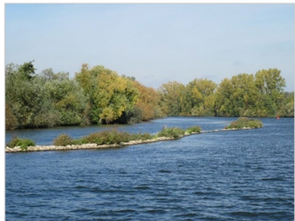
Parallelwerk, zwei Jahre nach Fertigstellung 2012 (Quelle: WNA Aschaffenburg)
