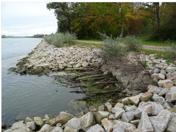
Fertiger Fischunterstand (bei km 359,000) 2019 (Quelle: BfG, Behrendt)
