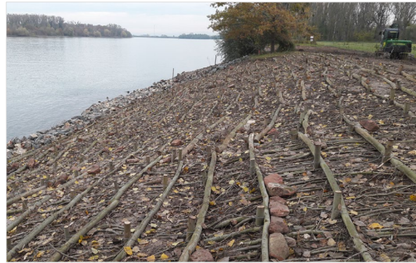
Zustand nach Bauabschluss 11/2019 (Quelle: BAW)
