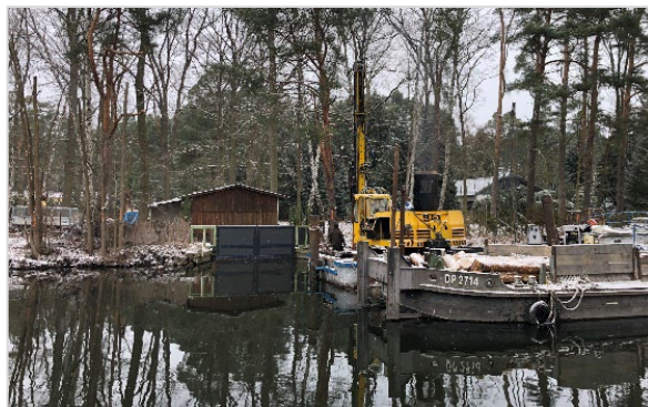
Einbau der Kiefernholzpfähle 02/2023 (Quelle: WSA Spree-Havel)
