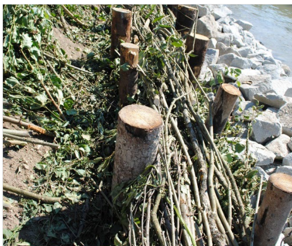
Einbau der Faschinen, bestehend aus Reisigbündeln, in die Doppelpfahlreihe 2014 (Quelle: WSA Donau/MDK)
