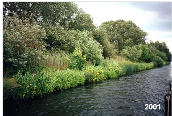
Zustand 8 Jahre nach Einbau - gut entwickelter lückenloser Bewuchs (Quelle: BAW)
