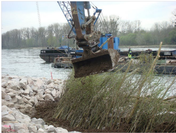
Einbau der Buschlagen in die Steinschüttung 2018 (Quelle: WSA Oberrhein, Neubert)
