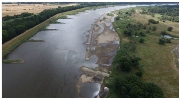
Parallelwerk Reitwein, im Jahr der Fertigstellung bei Niedrigwasser 09.07.2019 (Quelle: WSA Oder-Havel)
