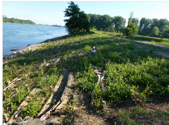
Weidenspreitlage mit ersten Austrieben 05/2020 (Quelle: WSA Oberrhein)
