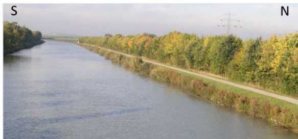
Blick auf das Nordufer 2005 (Quelle: BAW)
