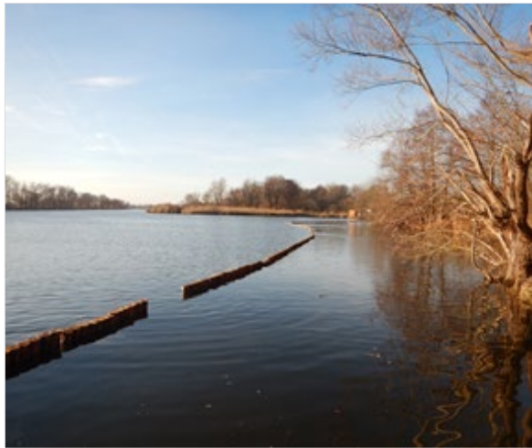
Bereich UHW-km 32 (1. Bauabschnitt) nach Einbau 2015 (Quelle: WNA Berlin)
