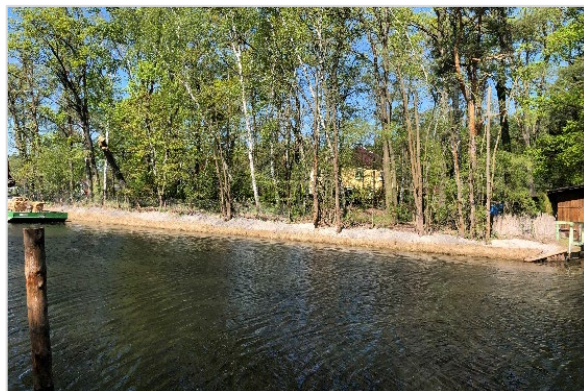
Einbau der Pflanzmatten 04/2023 (Quelle: WSA Spree-Havel)
