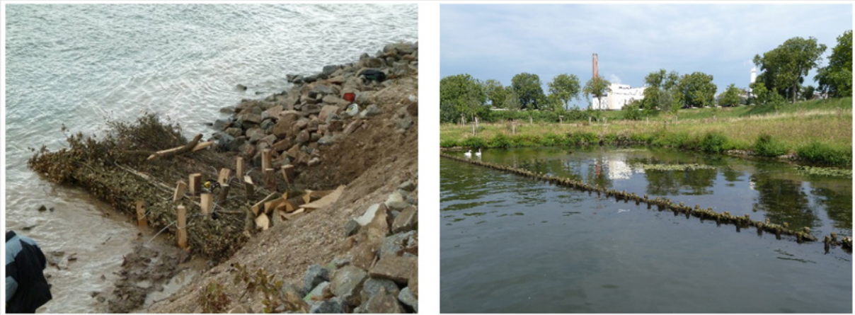
Abbildung 10: links: Einbau einer Totholzfaschine am Rhein bei Worms, rechts: Zweireihige Palisaden aus Holzpfählen mit zwischengelagerten Totholzfaschinen am Neckar bei Ladenburg (Fotos: K. Behrendt, BfG)
