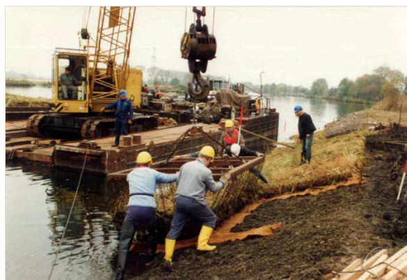
Einbau der Kammerdeckwerke (KDW) 1993 (Quelle: BAW)
