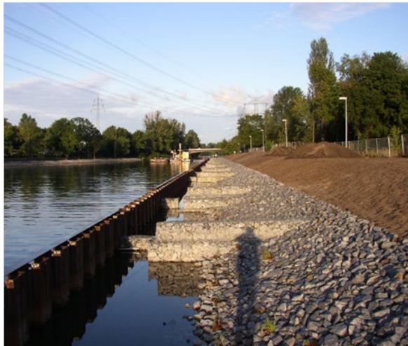
Bauzustand 2003 (Quelle: WNA Berlin)
