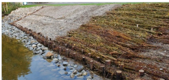
Faschinenmatten aus Faschinenbündeln (Weidenwippen) 2014 (Quelle: WSA Donau/MDK)
