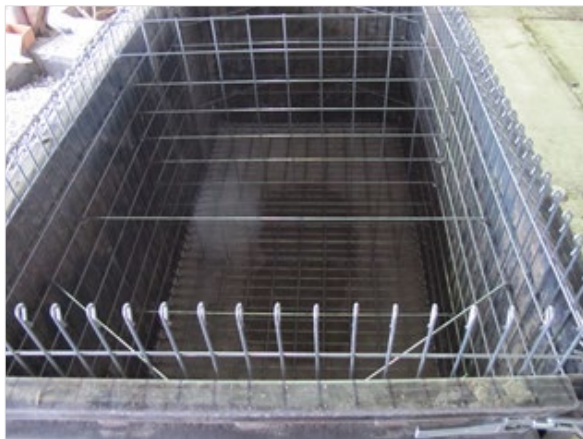
Zusammenbau einer Gabionenkiste 01/2013 (Quelle: WSA Oder-Havel)
