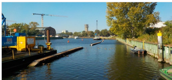
Bauzustand – eingebrachte vorgelagerte Wellenschutzspundwand 10/2024 (Quelle: WNA Berlin)
