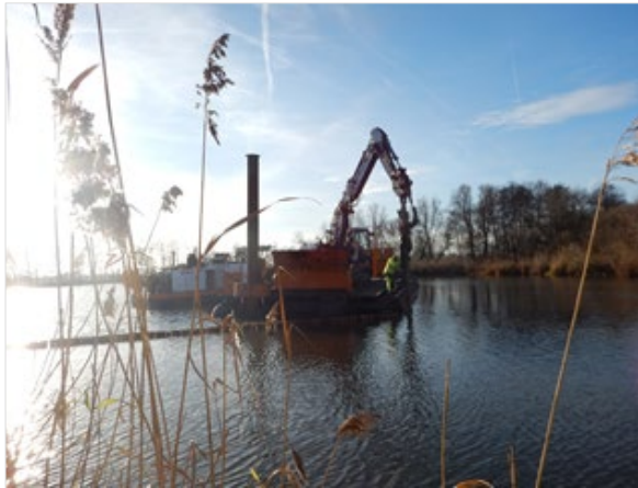
Einbau der Pfahlpakete (1. Bauabschnitt) 2015 (Quelle: WNA Berlin)
