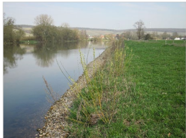
Uferbereich, ein Jahr nach Fertigstellung 2013 (Quelle: WNA Aschaffenburg)
