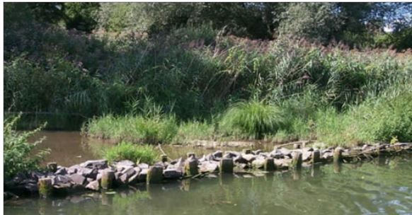
Flachwasserzone und Doppelpfahlreihe mit bewachsenem Uferstreifen 08/1999 (Quelle: Stadt Eberbach)
