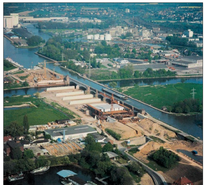
Bild 5: Luftbild Errichtung Flut- und Strompfeiler (1996)
