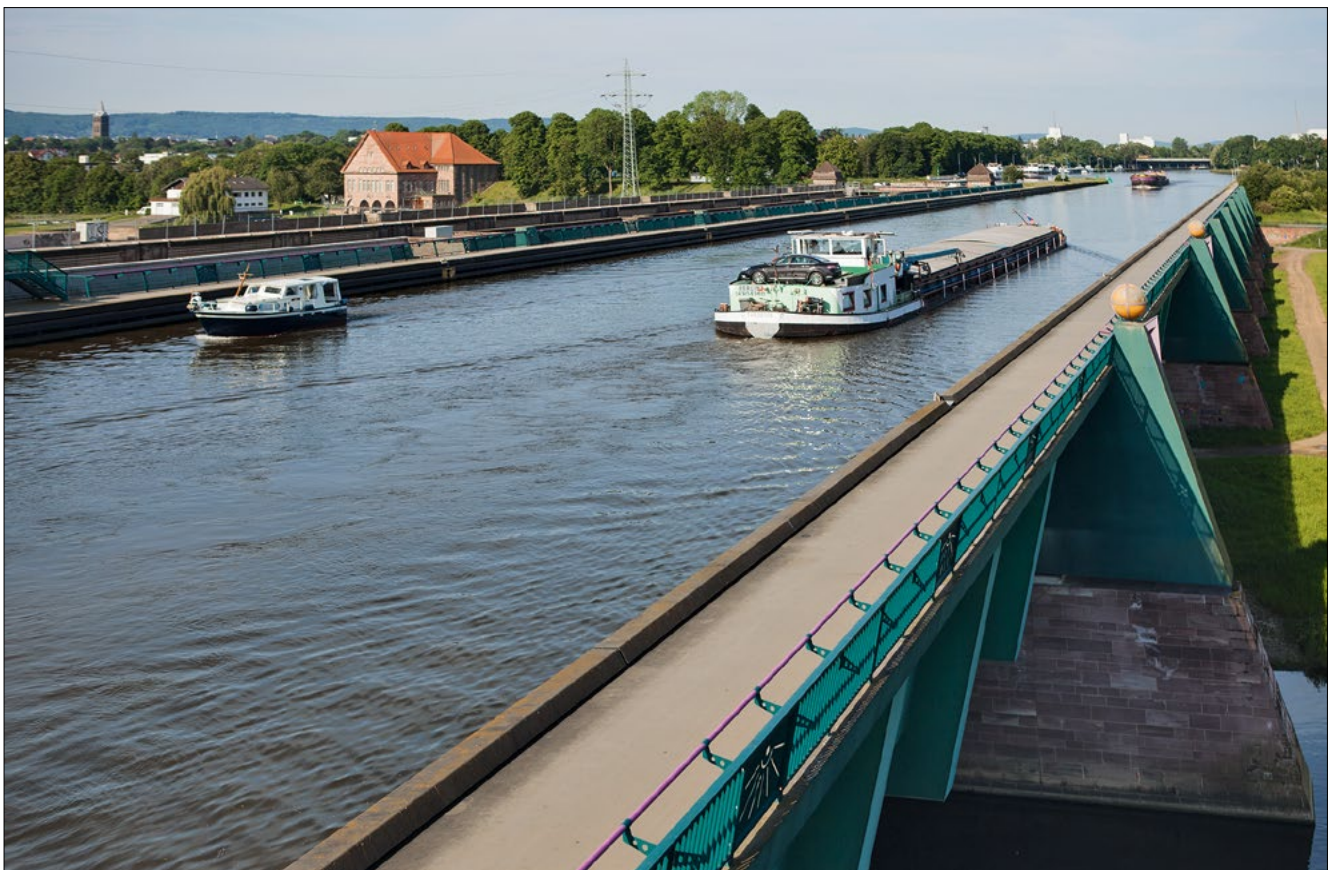
Bild 7: Ansicht von Nord-Ost, im Hintergrund das Hauptpumpwerk (2014)
