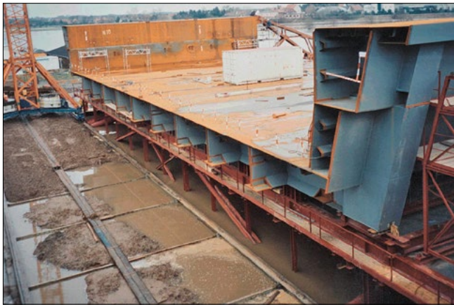
Bild 6: Segment Überbau Kanalbrücke (1996)
