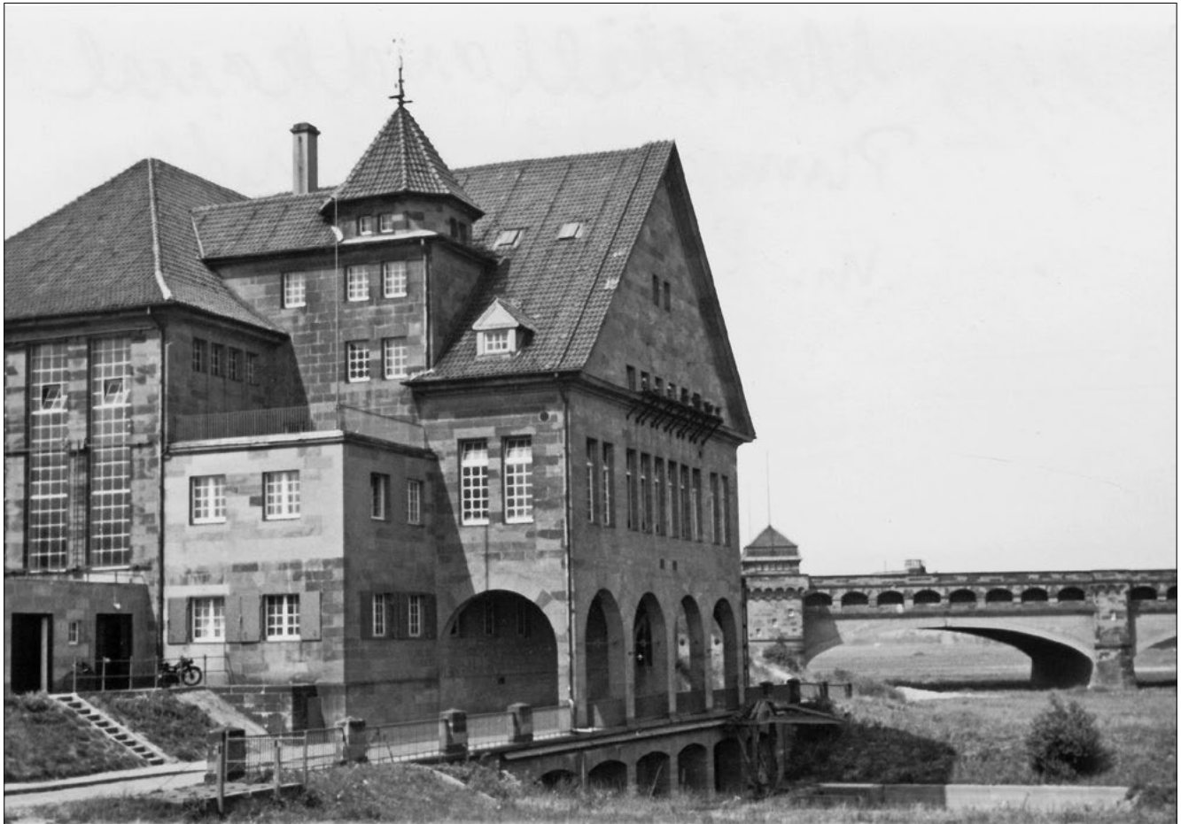
Bild 9: Hauptpumpwerk Minden, Ansicht von Süden (1930)
