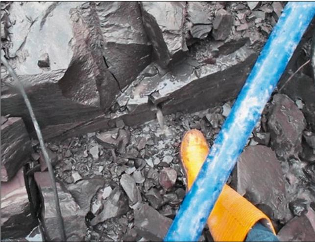
Bild 18: Wasseraustritte im Tonstein beim Aushub der Baugrube
